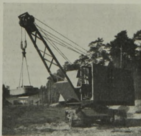
Abb. 1. Umbaubagger als Stampfgerät auf einer Baustelle der Reichsautobahn Frankfurt (Main)—Mannheim.
