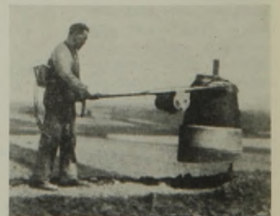
Abb. 8. Delmag-Stampfer, Explosionshandramme.
