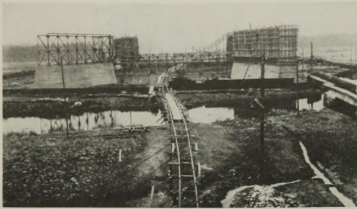
Abb. 23. Kanalüberführung Stever. Betonierung des südwestlichen Flügels im Pump-Torkretverfahren.
