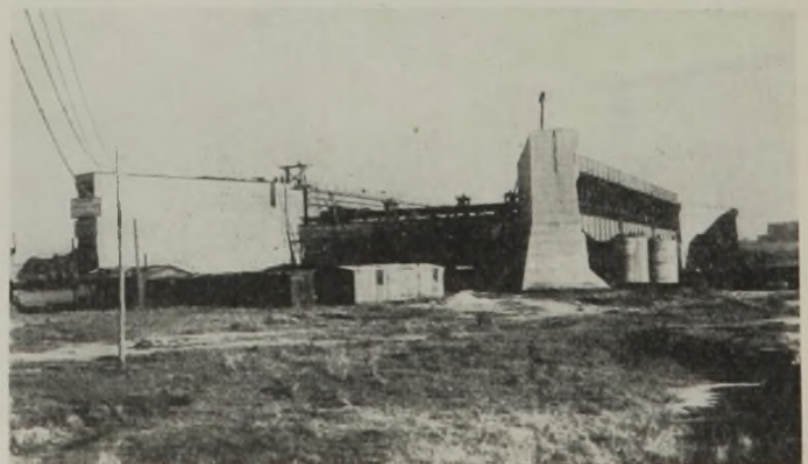
Abb. 22. Kanalüberführung Lippe. Kurz vor der Vollendung.
