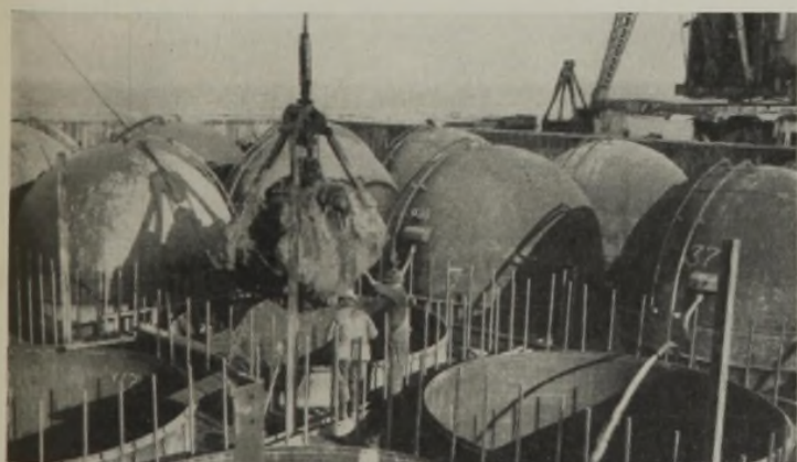
Abb. 5. Senkkasten des großen Mittelpfeilers auf der Westseite. Ausbaggern des Bodens nach Entfernen der kuppelförmigen Stahldeckel mit Hilfe von Greifern.
