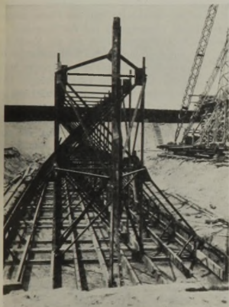
Abb. 29. Kanalüberführung Lippe. Eisenfachwerk-Bewehrung der Strompfeiler.
