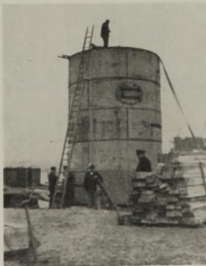
Abb. 15. Wasserbehälter zur Entlastung der Kaimauer.
