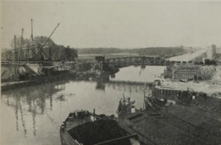
Abb. 45. Montage einer Brücke am Hafen Datteln.
