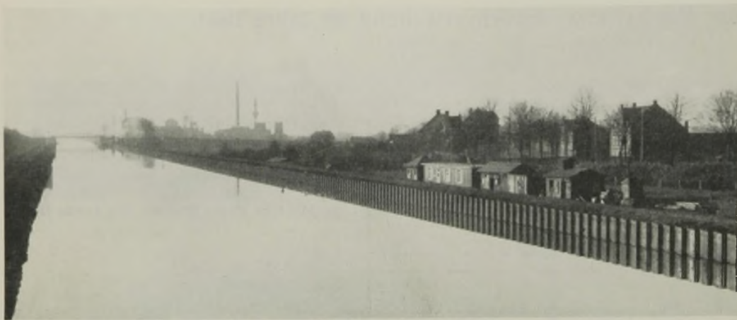
Abb. 47. Kanalerweiterung mit Spundwänden bei Datteln.
