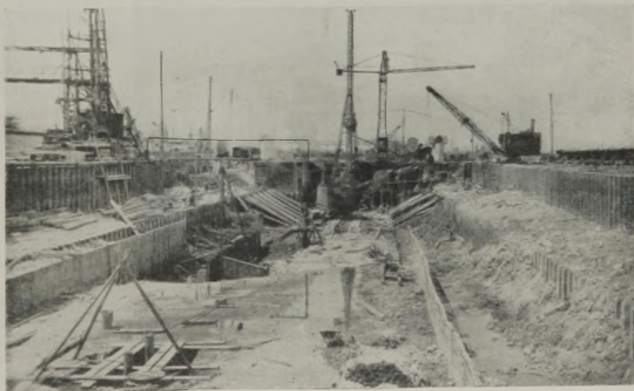
Abb. 12. Baugrube der kleinen Kammer.
