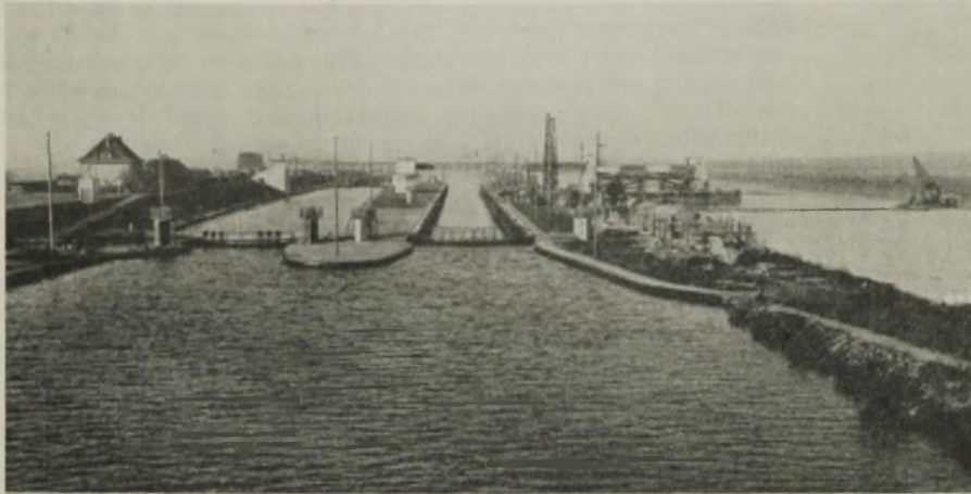
Abb. 15. Blick auf die gesamte Schleusenanlage nach Fertigstellung des Umbaus.
