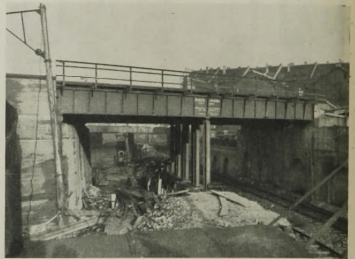
Abb. 5. Kreuzungsbauwerk auf Bahnhof Düsseldorf.
