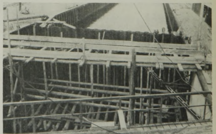
Abb. 8. Unterwasserseitiger Baugrubenumschluß der kleinen Kammer.
