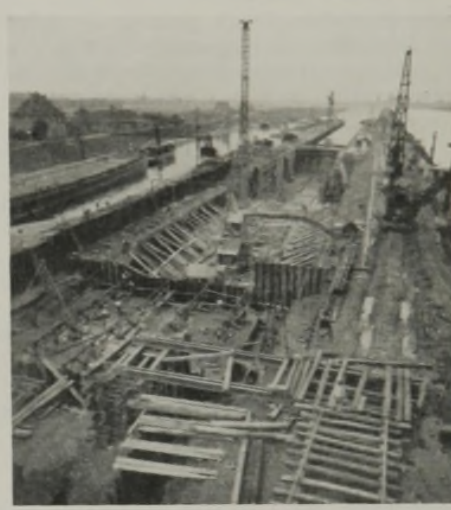
Abb. 13. Bauausführung der kleinen Kammer.
