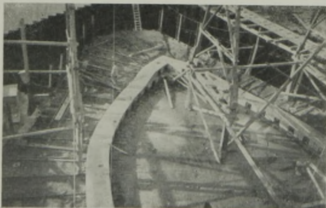
Abb. 7. Verankerung der Spundwände des Schleusenvorkopfes im Unterwasser.
