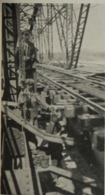
Abb. 10. Einziehen des Untergurtes des neuen Querträgers durch den ausgeschnittenen Längsträger.
