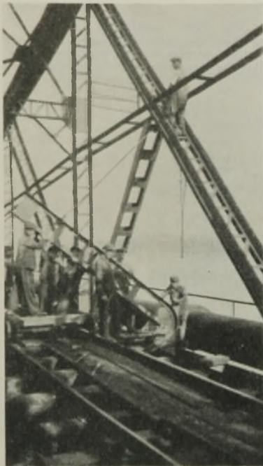
Abb. 13. Montage des neuen Hilfs- ständers.
