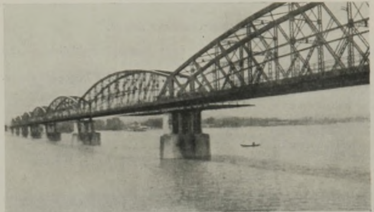
Abb. 2. Ansicht der Donaubrücke.
