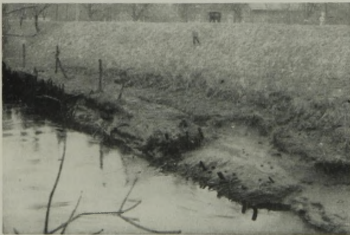
Abb. 5. Vor der Befestigung der Ufer.
