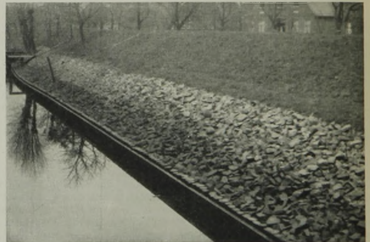
Abb. 6. Nach der Befestigung der Ufer.
