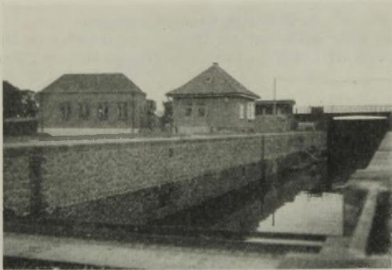
Abb. 53. Schleuse Brienen nach dem Umbau (Erhöhung der Kammer um 1 m und Elektrisierung).
