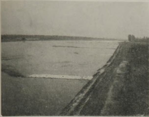
Abb. 57. Niedrigwasserregulierung des Oberrhein. Ausgebaute Bühnenreihe oberhalb Kehl.
