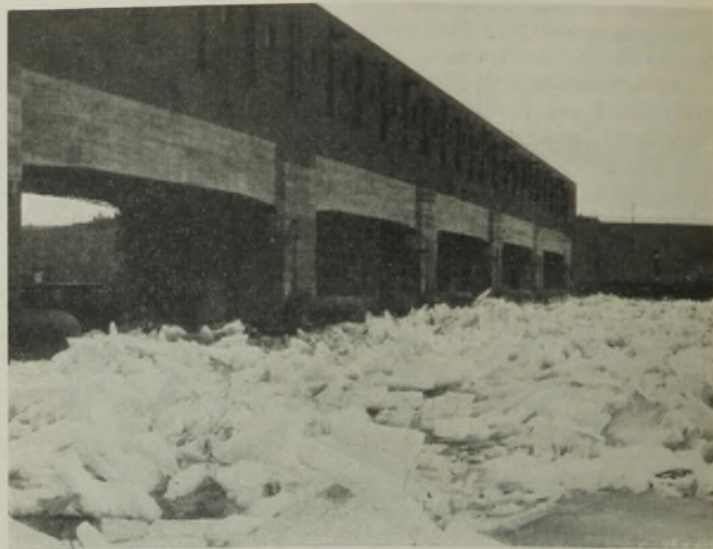
Abb. 62. Vor dem Kachlet-Wehr am 6. Februar 1933 gestauter Eisstoß.
