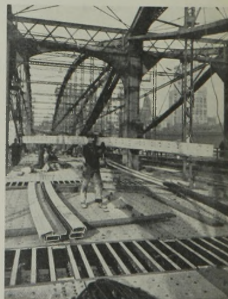
Abb. 1. Einbau der Fahrbahn für die Kraftfahrzeuge kurz vor der Fertigstellung.
