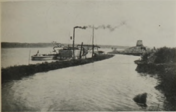
Abb. 9. Parallelwerk im Bau.
