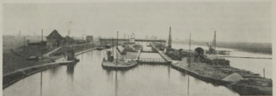
Abb. 60. Umkanalisierung des Unterrhein. Schleusenanlage Kostheim.
