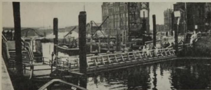
Abb. 17. Notbrücke für Gehverkehr.
