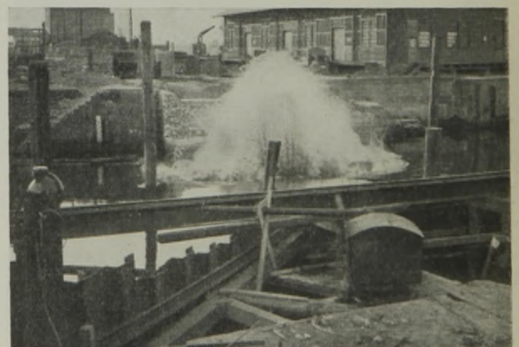
Abb. 25. Sprengung des Unterwassermauerwerks.
