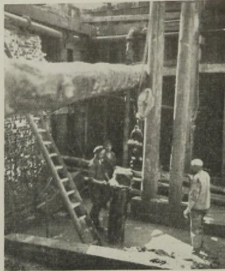
Abb. 23. Ziehen der alten Rostpfähle mittels Dampfhammer und Flaschenzug.
