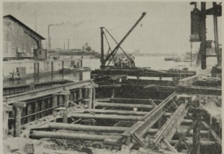
Abb. 19. Absteyfung der Baugrube.
