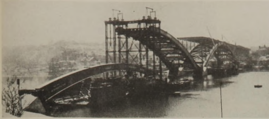
Abb. 1. Die Baustelle der Mälarseebrücke in Stockholm im Februar 1934. Einschwimmen und Absetzen der landseitigen Hälfte des großen Stahlbogens.
