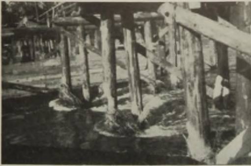
Abb. 13. Das Rammgerüst nach dem Eisgang am 3. Februar 1933.
