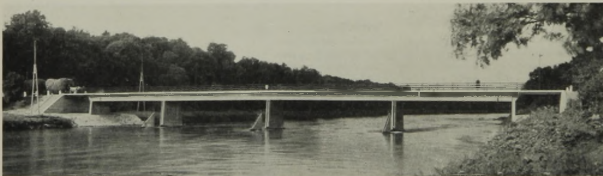
Abb. 14. Die neue Brücke von Oberstrom.
