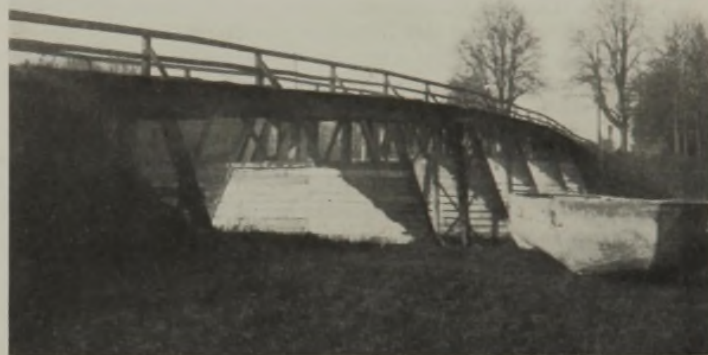
Abb. 2. Ansicht der im Jahre 1840 erbauten Holzbrücke.
