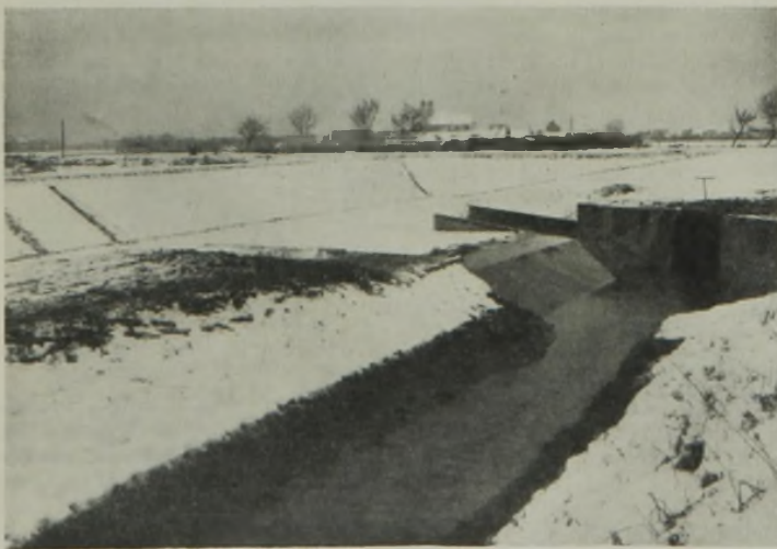
Abb. 3. Ehemalige Versickerungsstelle des Hachinger-Baches bei Berg am Laim, nunmehr Einmündungsstelle in das Ableitungsrohr zum Hüllgraben und Elsablaß.
