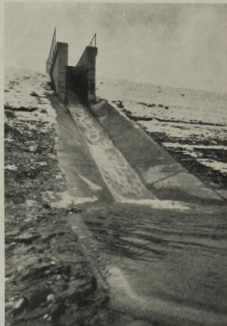
Abb. 7. Einmündungsbauwerk des Verbindungsgrabens in den Abfanggraben der „Mittleren Isar AG.“
