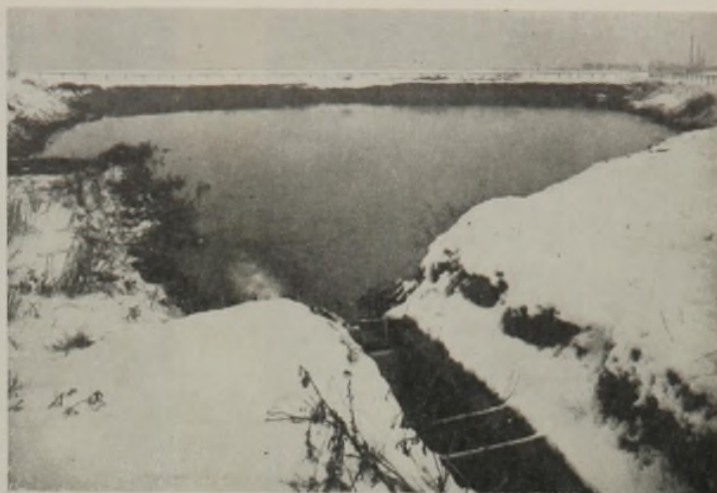
Abb. 6. Behelfmäßige Versickerungsanlage des Hachinger Baches in eine Kiesgrube bei Perlach.
