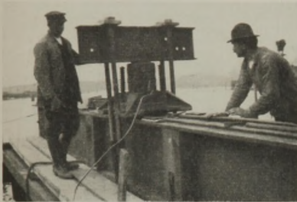
Abb. 20. Einrichtung für die Zugversuche.
