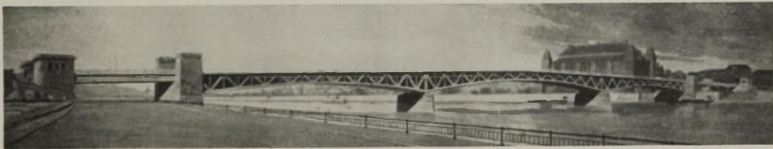
Abb. 2. Ansicht der Horthy-Miklós-Straßenbrücke.
