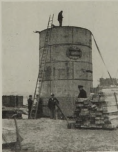
Abb. 15. Wasserbehälter zur Entlastung der Kaimauer.
