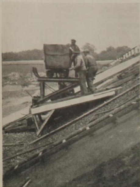
Abb. 10. Abladen der Einbaumasse an der Einbaustelle.
