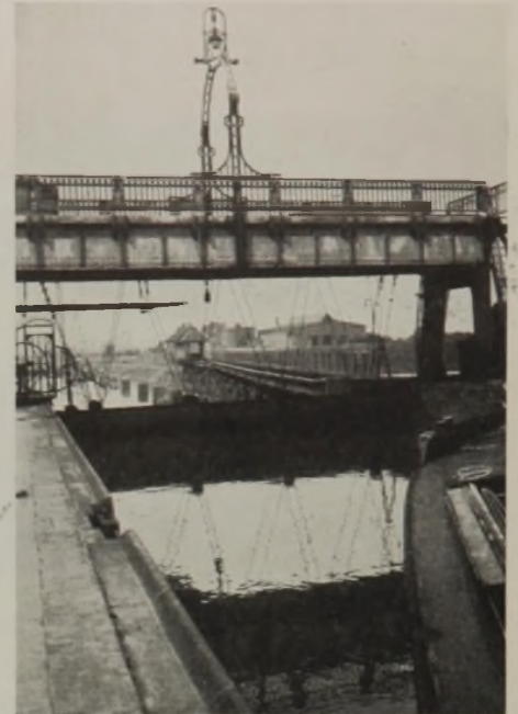
Abb. 5b. Das Untertor der nicht gesunkenen Schleuse V bei gefüllter Kammer.
