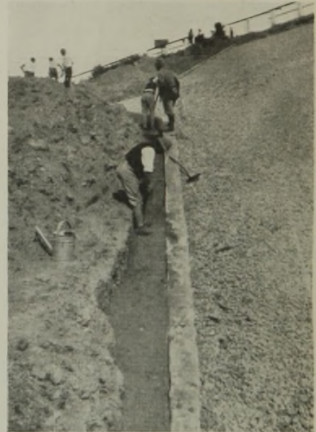
Abb. 8. Einbringen des Lehmsporns vor der Herdmauer.
