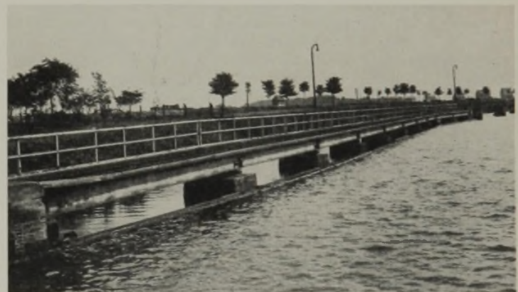
Abb. 6b. Das obere Leitwerk der nicht gesunkenen Schleuse V.
