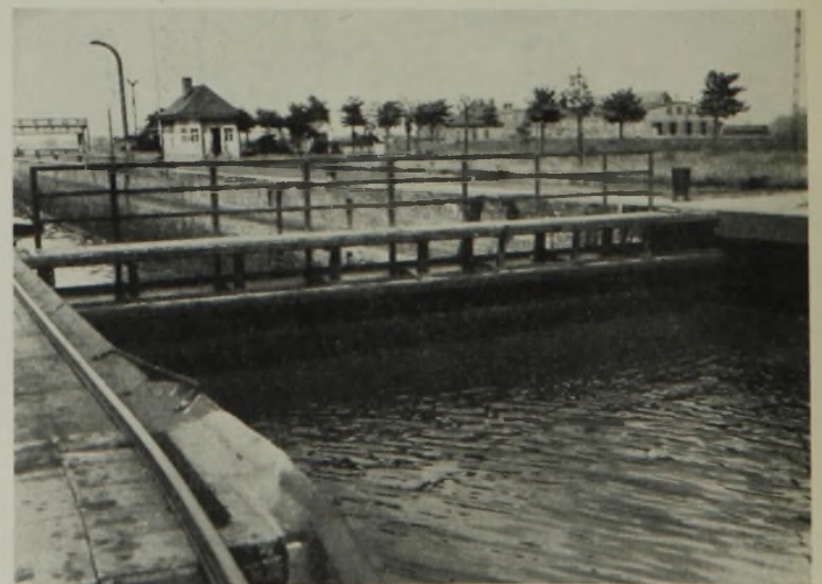
Abb. 4b. Das Obertor der nicht abgesunkenen Schleuse V.
