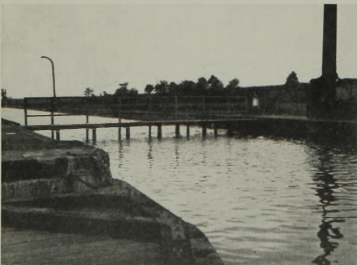
Abb. 4a. Das überflutete Obertor der gesunkenen Schleuse IV.
