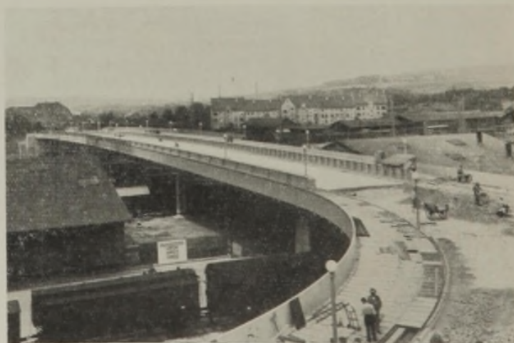
Abb. 33. Verlegen der Gehwegplatten.
