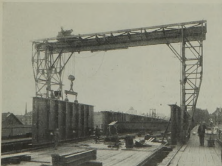
Abb. 28. Vorbau der Hauptträger.
