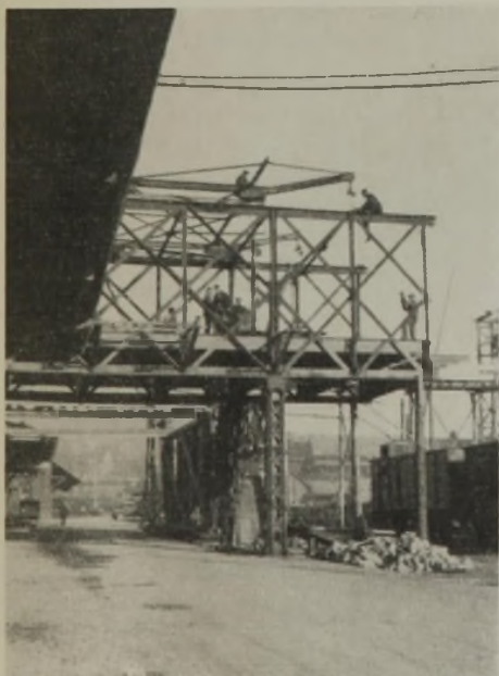
Abb. 22. Freirückbau beim Abbruch der alten Überbauten.
