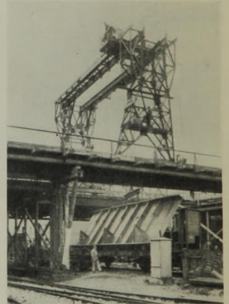
Abb. 27. Öffnung zum Hochziehen der Stahlteile.
