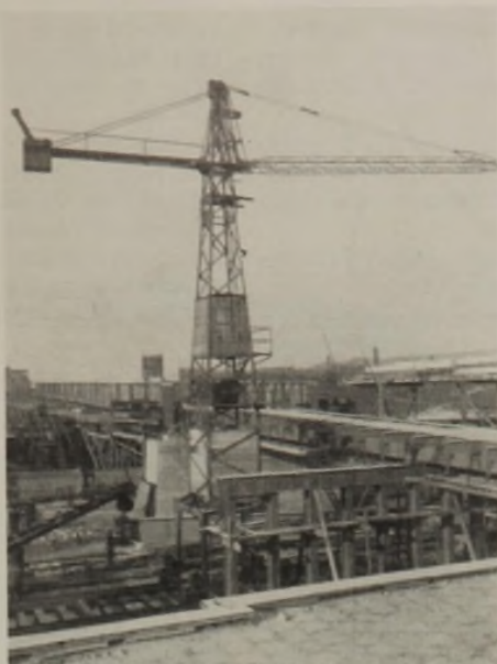
Abb. 31. Turmdrehkran zum Aufstellen der kleinen Überbauten.
