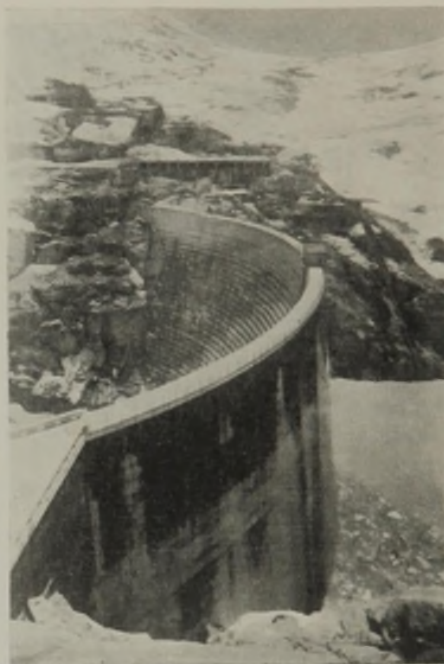
Abb. 1. Wasserseitiger Bitumenanstrich der Spitallammsperre (Grimselwerk).
