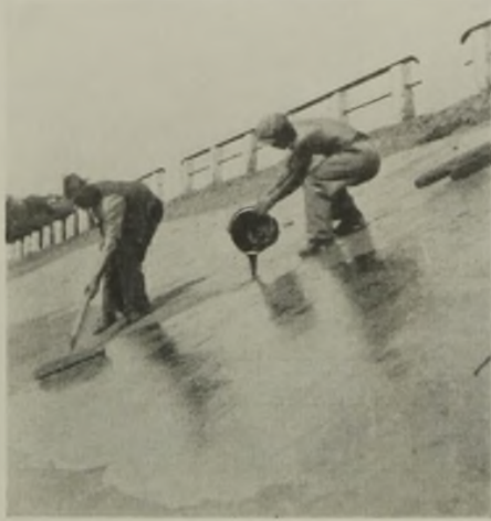
Abb. 16. Nachbehandlung der Decke mit Bitumen.
