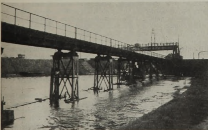
Abb. 7a. Das gesunkene untere Leitwerk der Schleuse IV.
