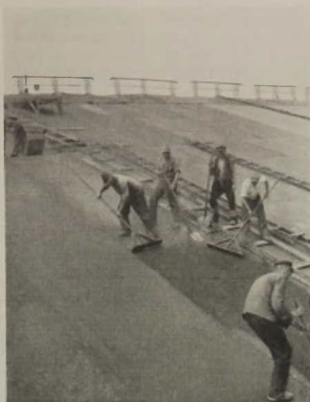
Abb. 11. Gleichmäßiges Ausbreiten der Einbaumasse.
