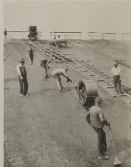
Abb. 12. Abwalzen mit 800-kg-Walze.
