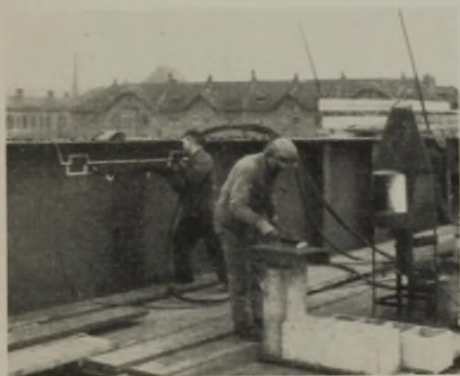
Abb. 30. Nieten mit Stauchhammer.
