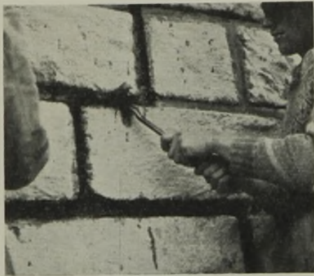
Abb. 2. Abdichtung mit kaltverstreichbarer Bitumenpaste.
