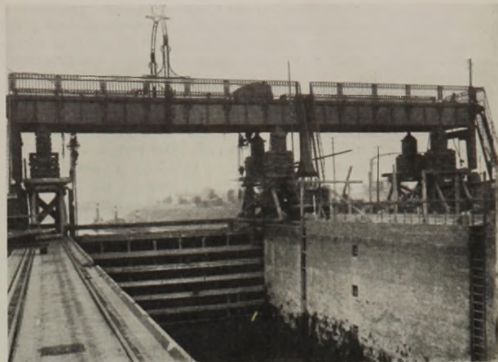
Abb. 14. Die Torbrücke des Unterhauptes der Nordschleuse IV wird um 2 m gehoben.
