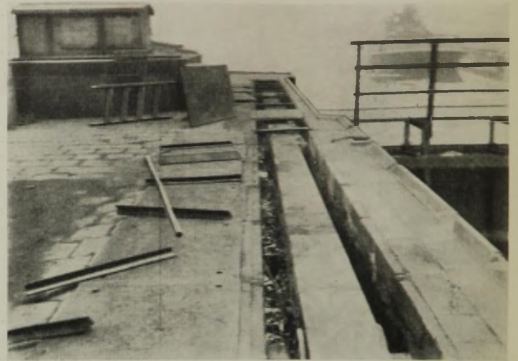
Abb. 9. In den Schubstangenkanal im Oberhaupt der gesunkenen Schleuse IV sind Eisschollen hineingeschwommen und behindern die Bewegung des Tores.
