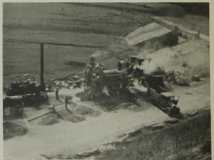
Abb. 9. Walzasphalt-Mischmaschine, rechts der Ameckerdamm.
