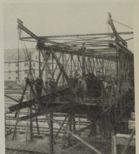
Abb. 23. Abbruch des alten Überbaues.
