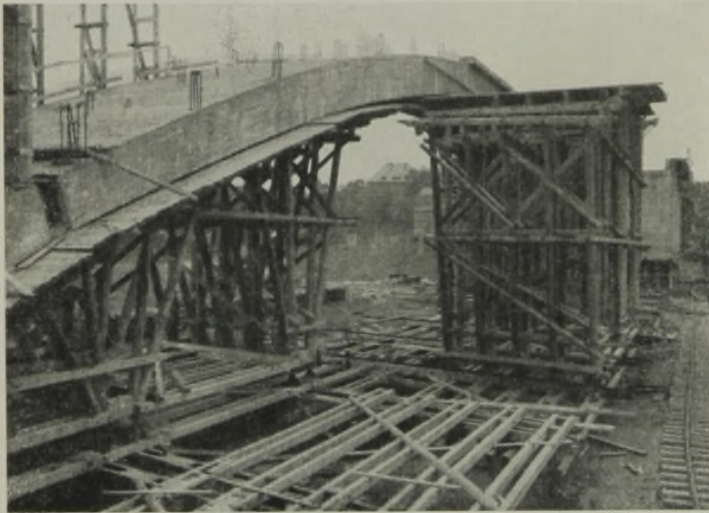
Abb. 34. Das Verschieben der Gerüste.
