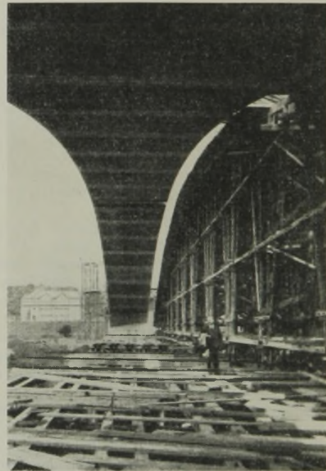
Abb. 35. Untersicht des ausgerüsteten Hohl Bogens nach Verschieben der Gerüste.
