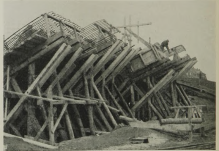
Abb. 28. Untergerüst und Bewehrung des Halses des linken Widerlagers.
