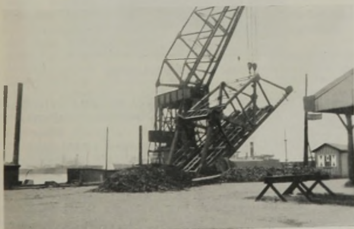
Abb. 26. Anheben des Klappenteiles mittels Schwimmkranes.
