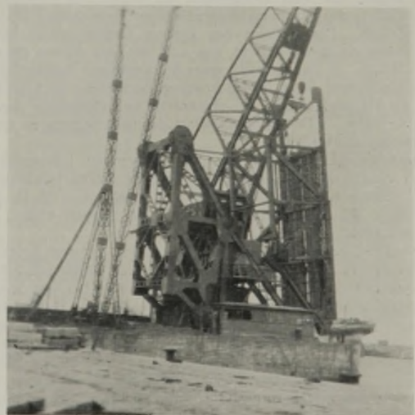
Abb. 26a. Der 148 t schwere Klappenteil wird mittels Schwimmkranes in die Lager gesetzt.
