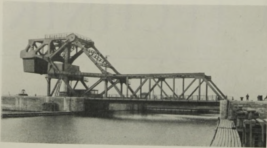
Abb. 2a. Brücke geschlossen.
