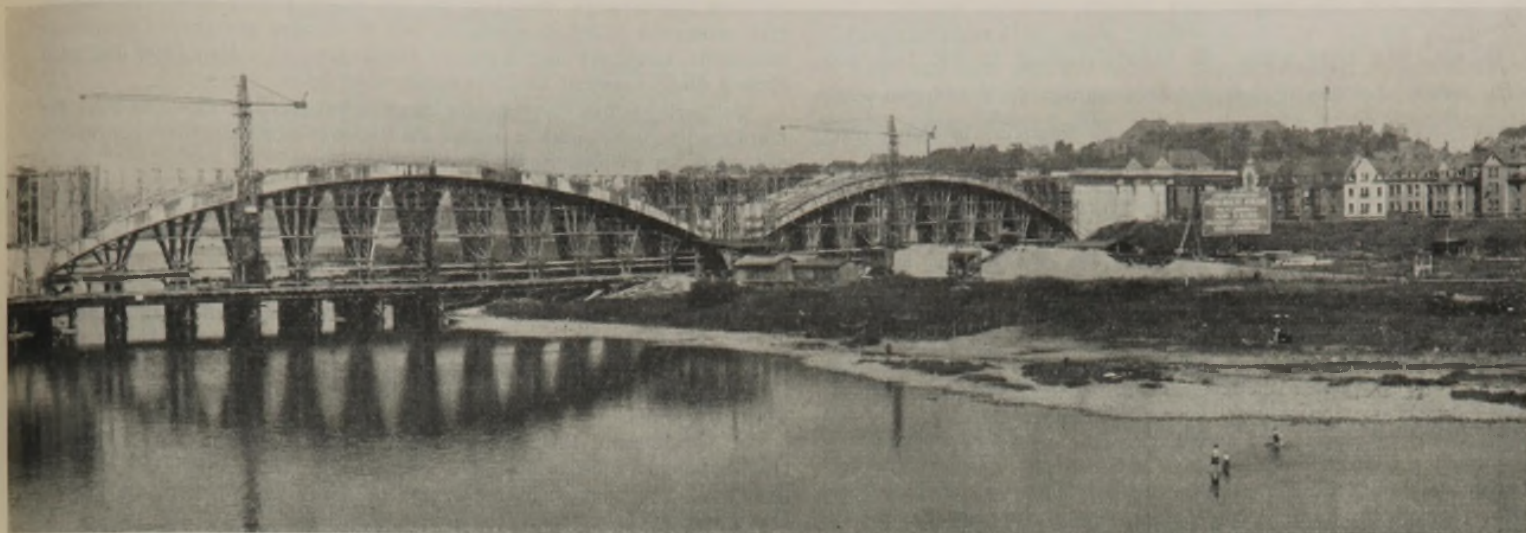
nach Beendigung der Betonierung. (Photo A. Urban, Koblenz).
