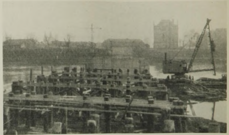
Abb. 8. Das Rammen des Untergerüsts mit einem Demag-Hammer und einem auf Pontons montierten Rampenbagger.
