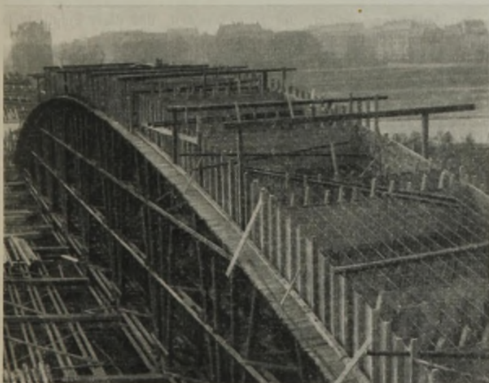
Abb. 32. Die Lamellenschalung des mittleren Massivbogens.
