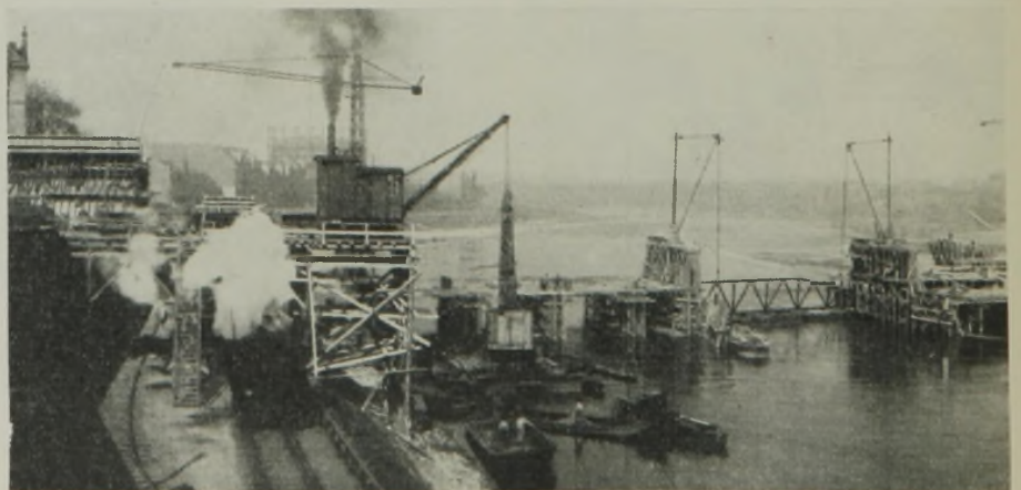
Abb. 10. Fortsetzung des Schaubildes Abb. 9. Hochziehen der Fachwerkträger zur Überbrückung der Schifffahrtöffnung. Ganz links der Entladekran für den Betrieb der Baustelle auf der Koblenzer Seite.
