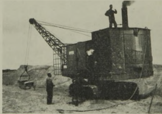
Abb. 4. Umbaubagger 3 mit einem 0,8-m 3 -Eimer (Demag).
