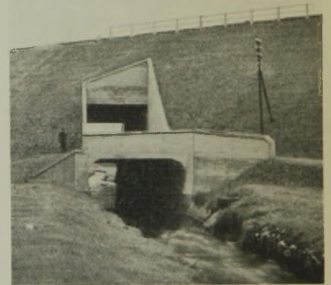
Abb. 14. Westansicht des fertigen Bauwerks.
