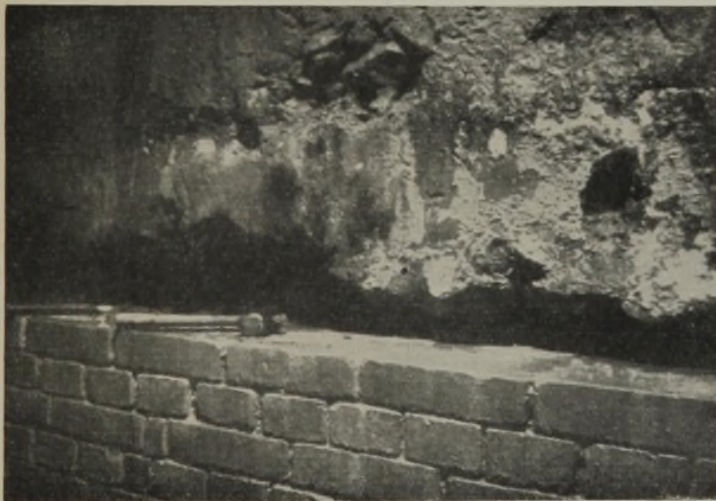
Abb. 5. Hochführen der Klinkerausmauerung.
