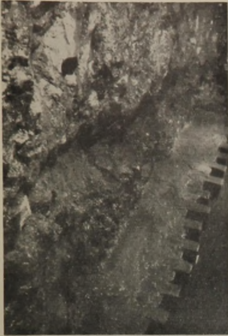
Abb. 4. Beginn der Klinkerausmauerung.
