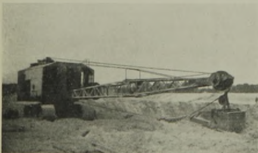
Abb. 3. Umbaubagger 2 mit einem 1,2-m 3 -Eimer (Menck & Hambrock G. m. b. H.).
