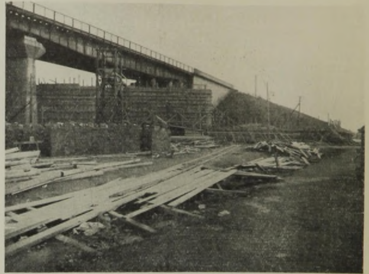
Abb. 7. Blick von Nordosten auf die Einrüstung des oberen Teiles des Stockwerkrahmens (14. 10. 32).
