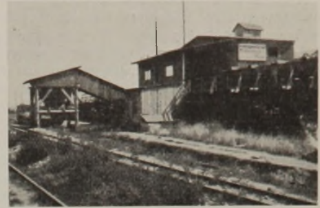
Abb. 8. Mischanlage und Trockenbetonsilo.
