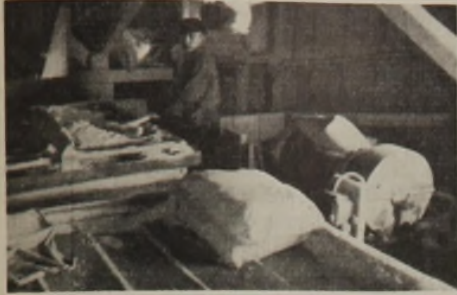
Abb. 5. Zement- und Traßsilo und Aufzug.
