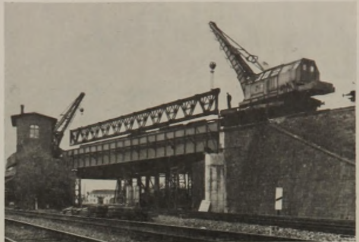
Abb. 7. Zweite Tragwand der alten Brücke schwebend.
