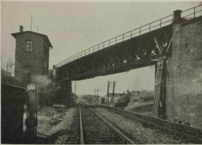
Abb. 1. Ansicht der alten Brücke.
