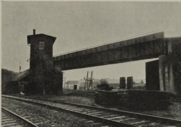
Abb. 8. Ansicht der neuen Brücke.
