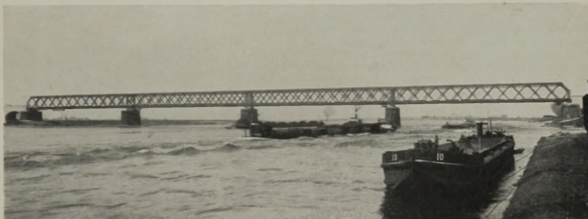
Abb. 1. Zweigleisige Eisenbahnbrücke über den Rhein bei Wesel.
