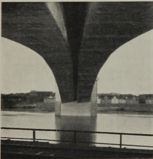
Abb. 55. Untersicht des rechten Bogens.
