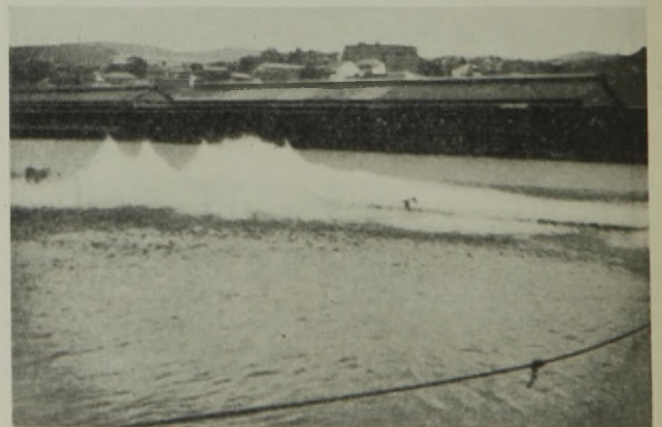
Abb. 8. Sprengung einer Reihe von 12 Bohrlöchern mit 24 kg Ladung bei 8 m Wassertiefe.
