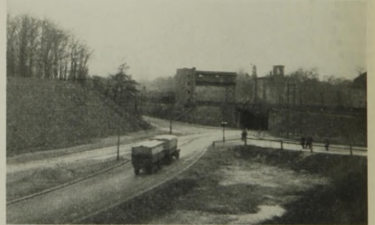
Abb. 25. Blick auf das alte Bauwerk von der verlegten Dreilindenstraße.
