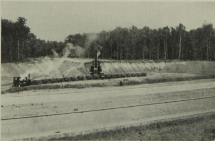
Abb. 23. Erdaushub in der Nibelungenstraße.
