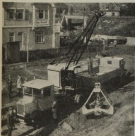
Kraftwagendrehkran beim Arbeiten mit einem Einseilgreifer (0,5 m 3 Inhalt).
