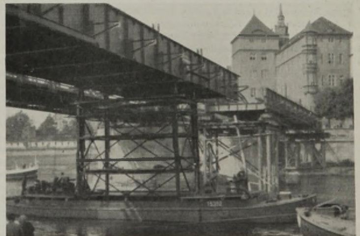
Abb. 16. Einschwimmen der zweiten Hälfte der Fahrbahntafel.
