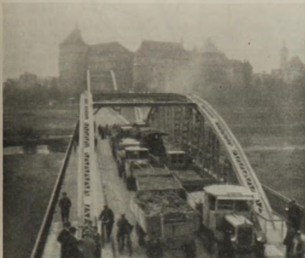
Abb. 20. Probelastung des Überbaues 5.
