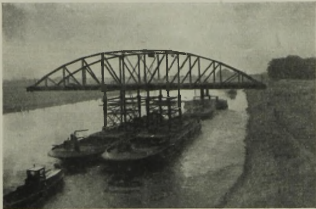
Abb. 17. Ausschimmen des Überbaues 2.
