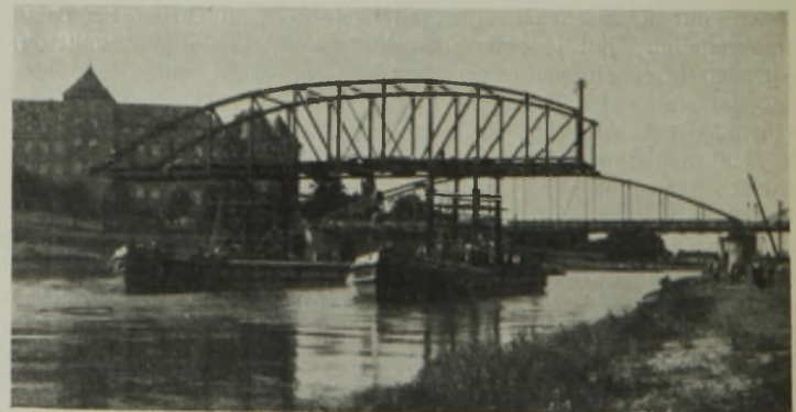
Abb. 19. Abtransport des Überbaues 3.
