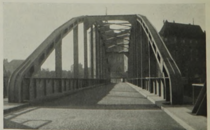
Abb. 14. Durchblick durch die neue Strombrücke.
