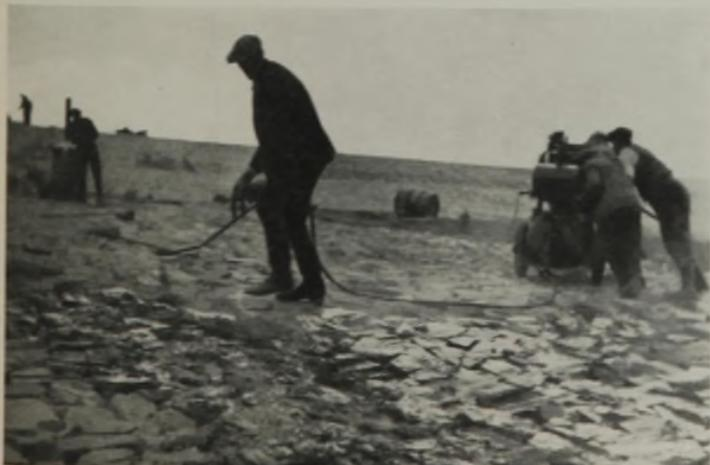
Abb. 3. Anspritzen der Steinpackung mit Spramex.
