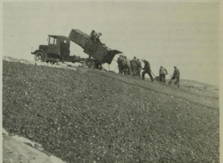
Abb. 8. Mit Asphalt vorbehandelte Kiesunterbettung.
