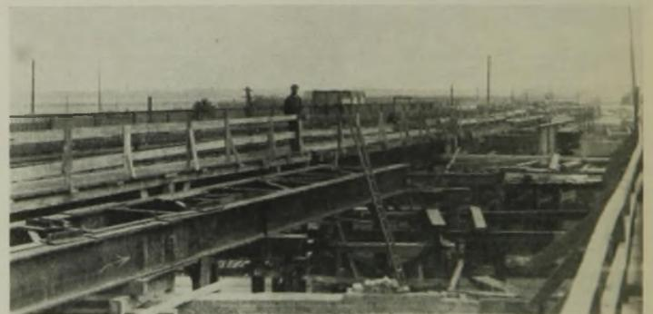
Abb. 22. Ausbau der alten Trogbauwerke des nördlichen Personengleises und der anschließenden Gleisbrücken.
