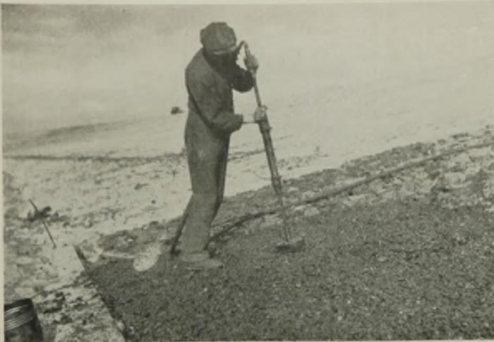
Abb. 5. Stampfen der Asphalt-Mineralmischung auf der Steinpackung.
