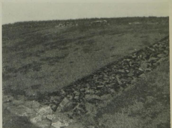
Abb. 9. Fertiger Asphalt-Sicherungsbelag. Der nicht gesicherte Streifen zeigt die Struktur der Unterbettung und des Belages.
