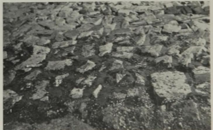
Abb. 4. Umrandung der Versuchsfelder durch Asphaltfugenverguß.
