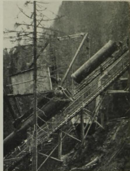
Hölzerner Mastenkran beim Verlegen von schweren Wasserrohren beim Bau eines Wasserkraftwerkes in Tirol.
