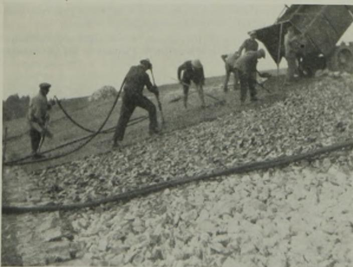
Abb. 7. Aufbringen des Asphalt-Sicherungsbelages auf einer Grobschotter-Unterbettung.
