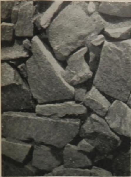
Abb. 1. 40 bis 60 cm dicke Steinpackung in Draufsicht.
