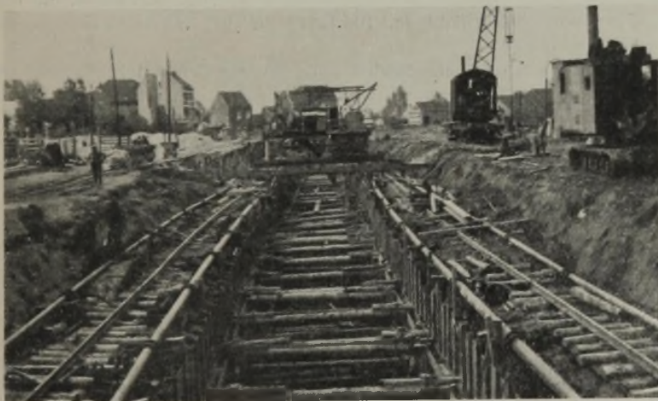
Abb. 6. Übersicht über die Baustelle Station 0 bis 100 m mit Voreinschnitt.
