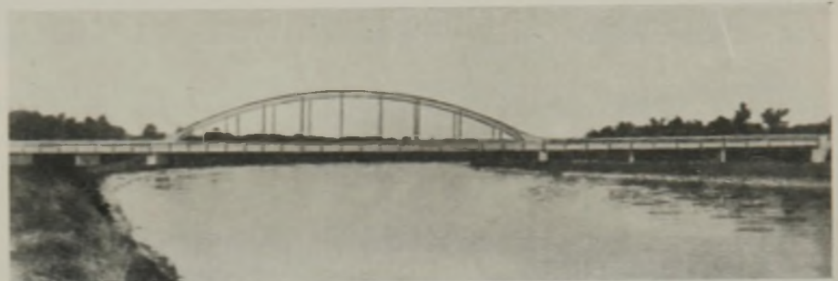
Abb. 4. Beispiel eines versteiften Stabbogens.
