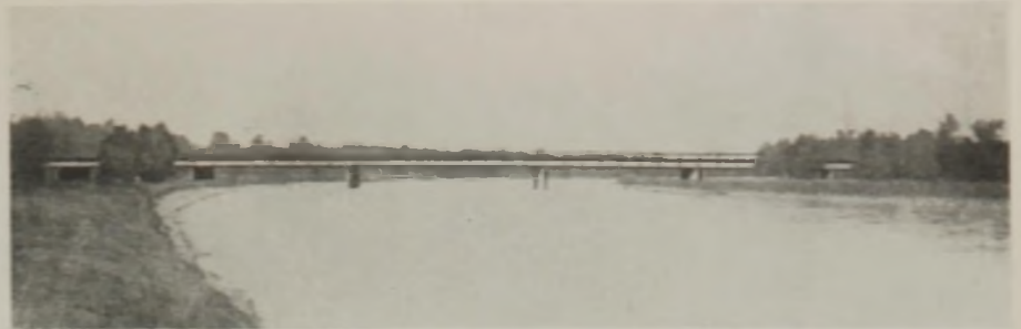
Abb. 3. Beispiel eines Blechbalkenträgers mit parallelen Gurtungen.
