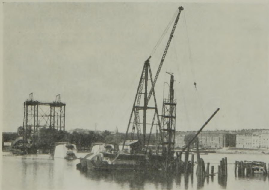
Abb. 18. Rammen eiserner Pfähle für die Gründung des Hebeturmes.
