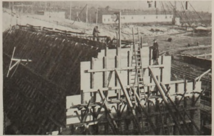
Abb. 20. Kopf des Ostpfeilers mit Auflagerbank und -steinen.
