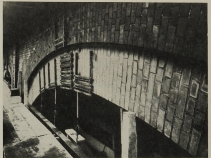
Die Meßrollen sind an einem Walzprofil befestigt, das auf einem sehr festen, außerhalb der Bogen stehenden, auskragenden Meßgerüst aufliegt.
