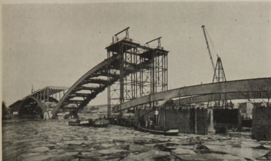
Abb. 26. Einschwimmen der 204-m-Bogen.
