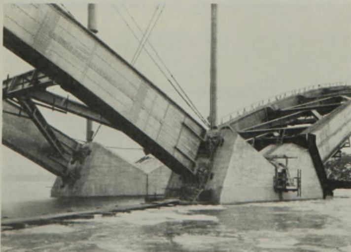
Abb. 10. Einspannung der Bogen an den Kämpfern.
