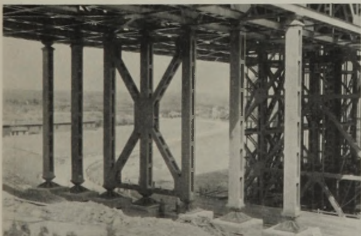
Abb. 6. Pendelwand über dem Ostpfeiler.
