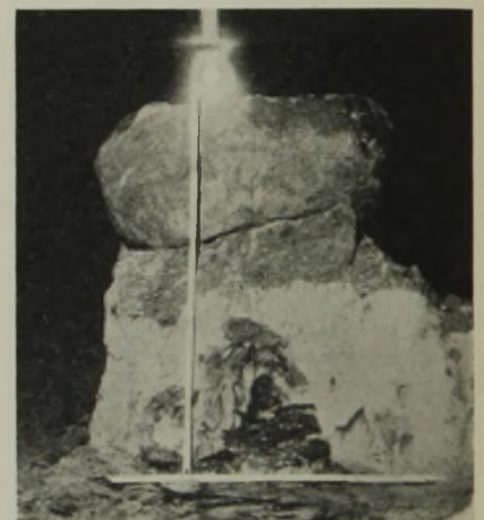
Abb. 2. Senkrechter Bodenanschnitt im Senkkasten des Ostpfeilers von NN — 9,4 bis — 10,4 m.
