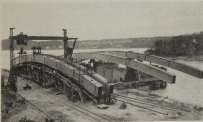
Abb. 14. Zwei Bogenhälften auf festem Nietgerüst in der Ekenbergs Werft, eine auf der Verschiebebahn und eine auf dem Schwimmdock.
