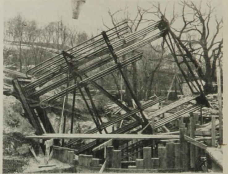
Abb. 9a. Ankerbolzen der Bogen usw. im Zwischenpfeiler.
