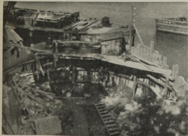
Abb. 6. Kreisförmiger Fangdamm auf Längholmer Ufer.
