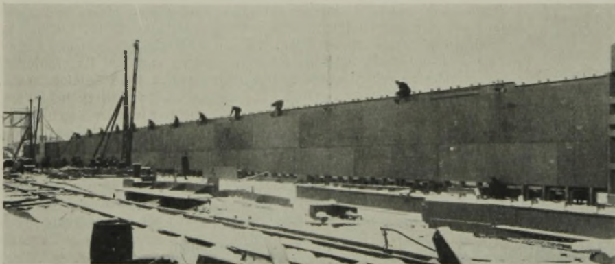
Abb. 27. Trogseitenwand in den Spindeln hängend.
