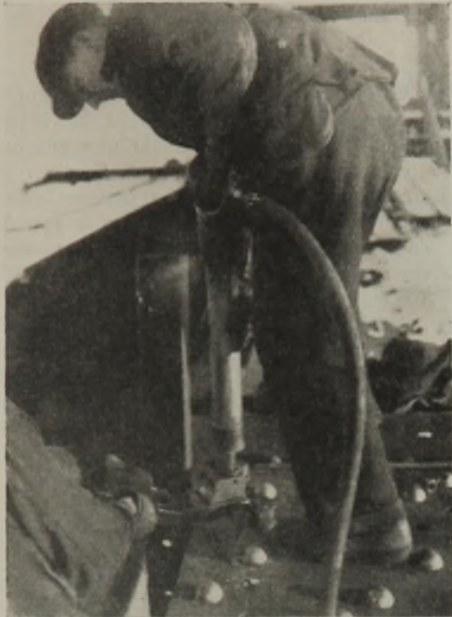
Abb. 40. Druckwasser-Nietmaschine mit 58 t Klemmkraft.
