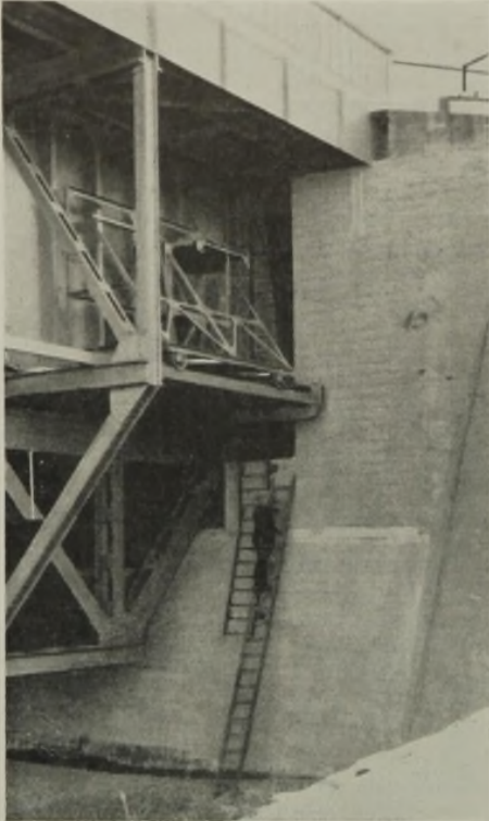
Abb. 19. Besichtigungswagen für die Trogseitenwände.
