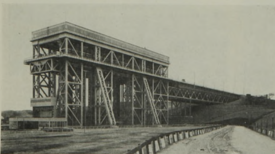
Abb. 28. Gesamtansicht von Norden.
