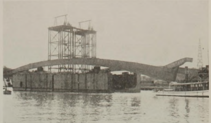
Abb. 21. Schnabelförmiger Vorsprung des Bogens am Kämpfer.
