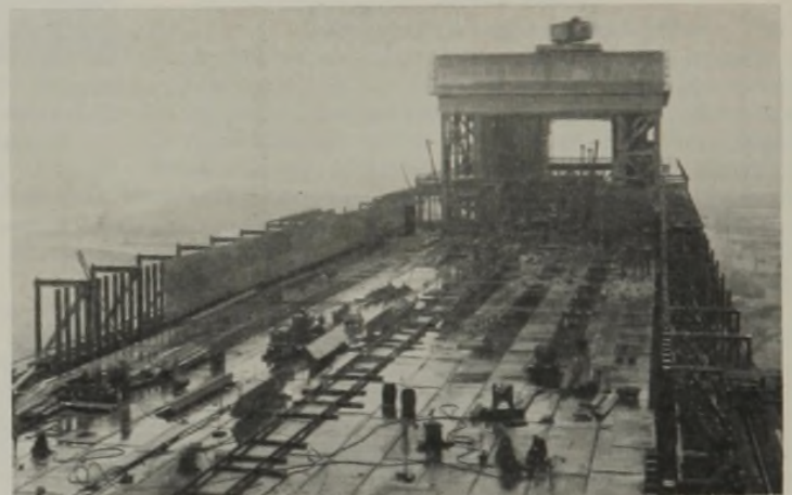
Abb. 7. Stand der Aufbauarbeiten 9. 2. 1933.
