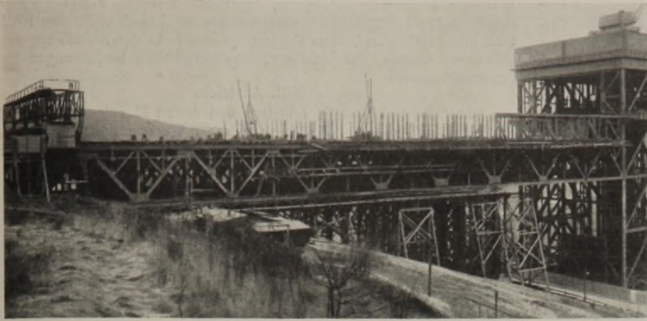
Abb. 22. Festes Holzgerüst unter der Kanalbrücke.
