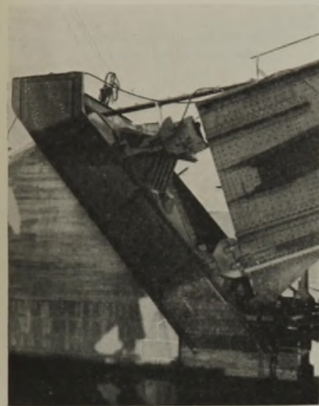
Abb. 22. Eindrehung eines Bogens über die Lagerkörper.
