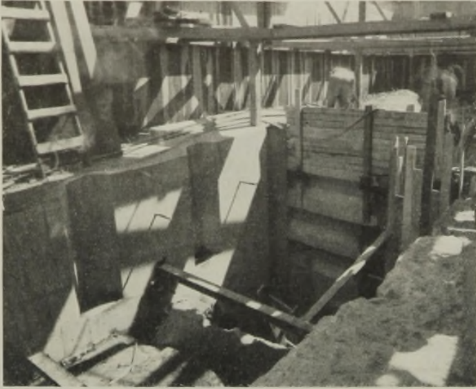
Abb. 8. Das Gießverfahren der Fundamente des Mittelpfeilers.
