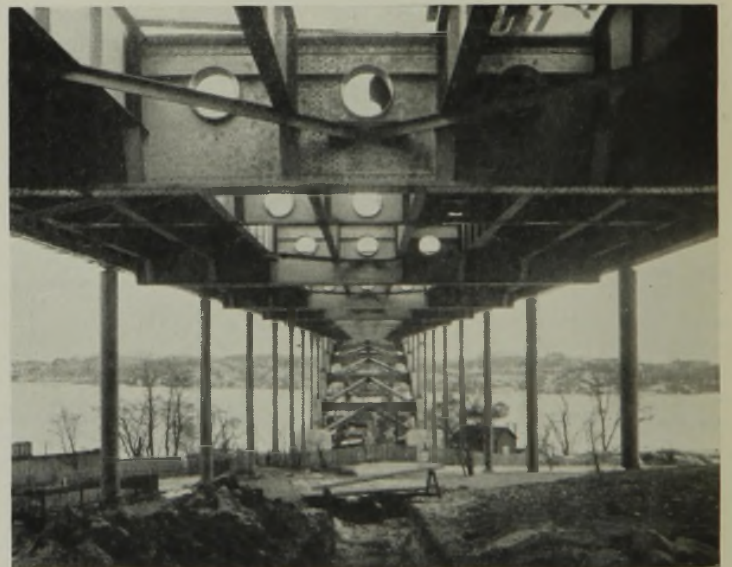
Abb. 32. Aufbau des ersten Viaduktfeldes auf Kungsholmen.
