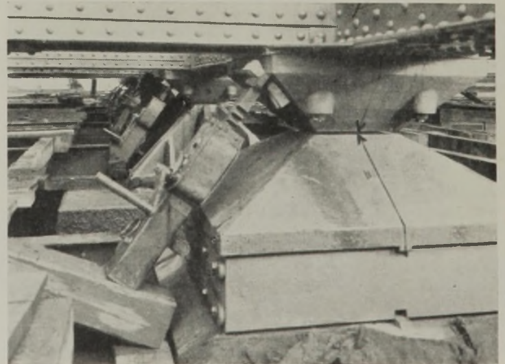
Abb. 25. Lager Westpfeiler in Endstellung.
