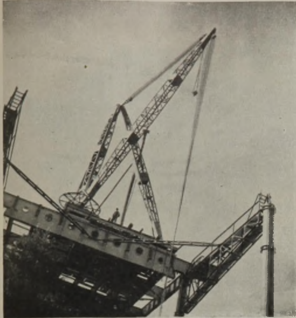
Abb. 33. Derrickkran mit 20 t Tragfähigkeit für Aufbau des Viaduktes.
