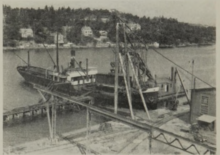
Abb. 13. Die Bogenteile werden am Ekenbergs Werfts-Kai entladen.
