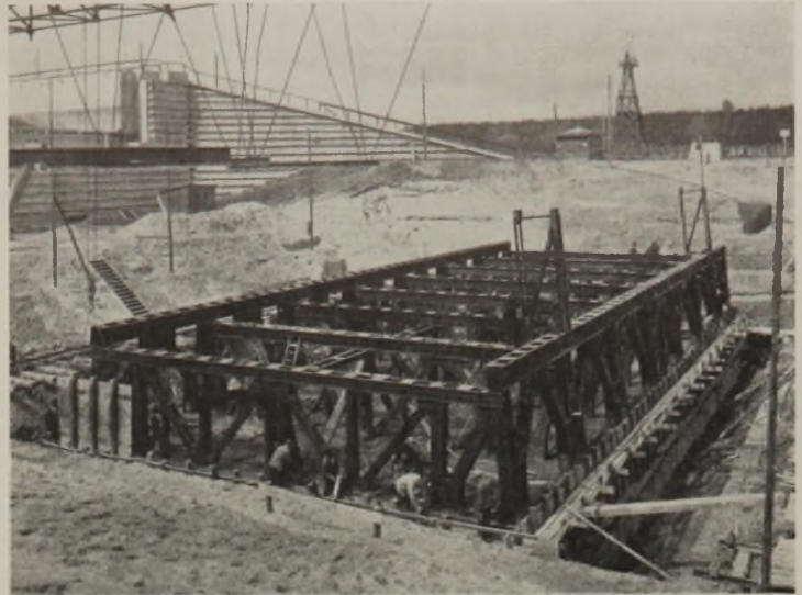
Abb. 9. Stahlgerippe des Westpfeilers bis Oberkante Decke des Arbeitsraumes ausbetoniert; links Landwiderlager der Kanalbrücke.
