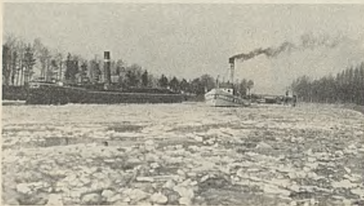
Abb. 12. Treibeis im Garzer Oberkanal, Blick zu Tal durch die Schleuse.
