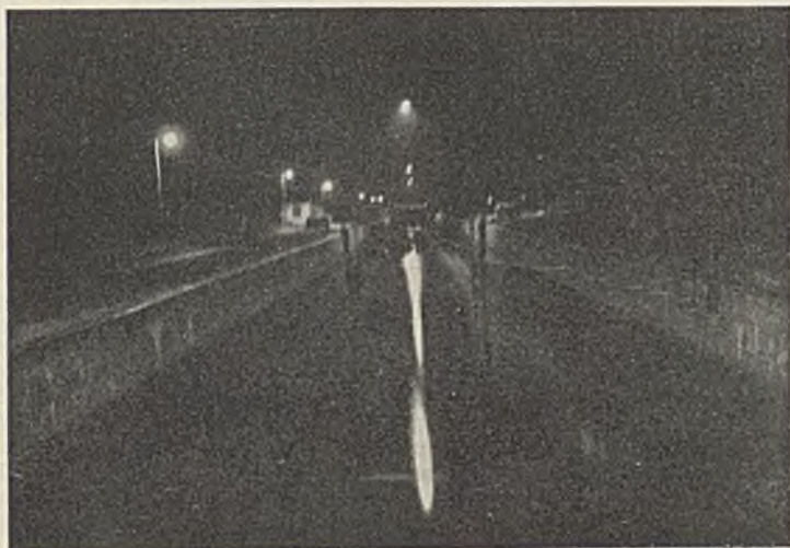
Abb. 21. Nachtbeleuchtung der Schleusen-kammer.
