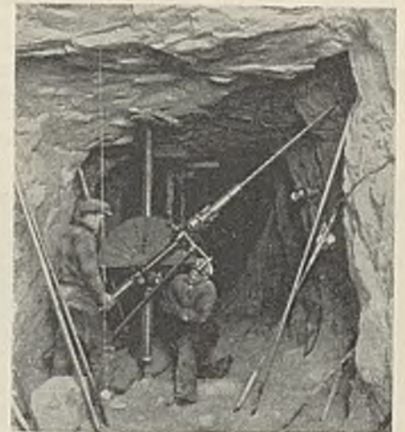
Abb. 15. Aufstellung der Bohrmaschinen beim Vollausbuch.
