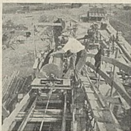
Abb. 19. Einbringen des Betons in die Bogen.
