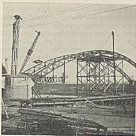
Abb. 16. Aufstellen der Eisenkonstruktion.
