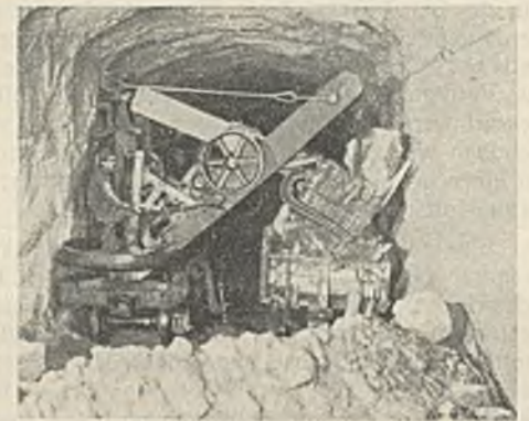
Abb. 23. Löffelbagger im Stollen. (Cascade-Tunnel.)
