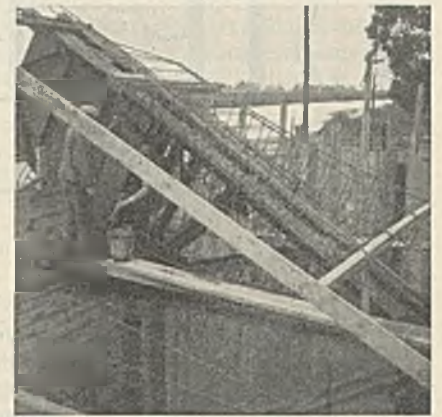
Abb. 6. Bewehrung der Widerlager der Rippenbogen.
