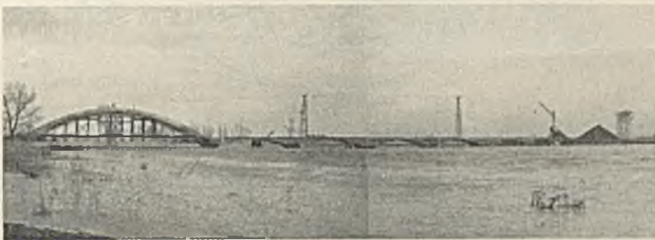
Abb. 25. Die Baustelle im Hochwasser.
