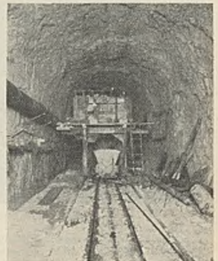
Abb. 25. Fahrbare Kippbühne mit darunter geschobenem Wagen beim Chicago-Avenue-Tunnel.
