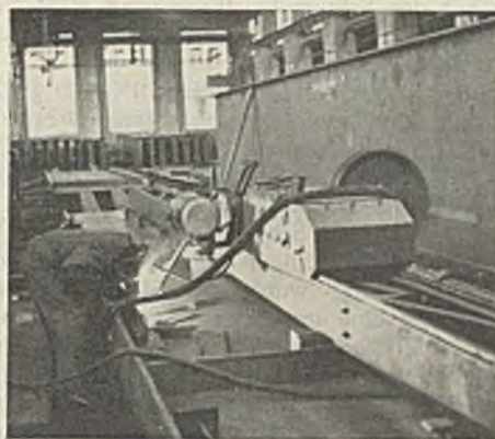
Abb. 21. Selbsttätige Schweißung des Hauptträgers.
