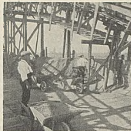
Abb. 20. Transport des Belastungsmaterials zur Mischmaschine.
