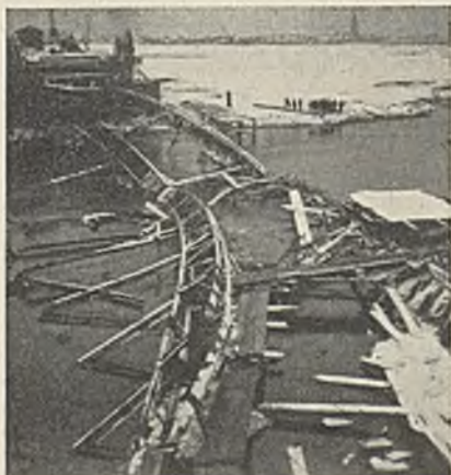
Abb. 26. Blick auf die zerstörte Eisenkonstruktion.
