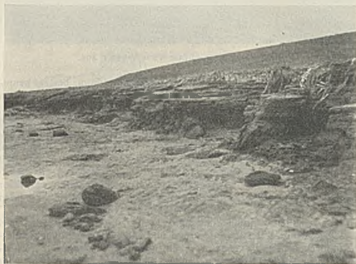
Abb. 15. Scharliegender Seedeich an der Nordwestspitze des Friedrichskooges.
