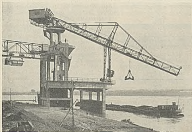
Abb. 1. Ufer-Schrägbahnlader für Ton und Kalkstein. Stundenleistung 100 t.
