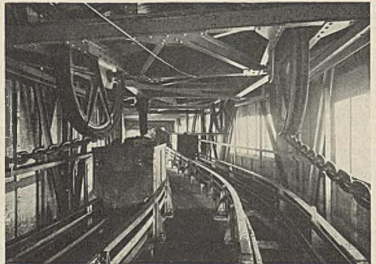
Abb. 5. Förderwagen an der Knickstelle der Förderbrücke.
