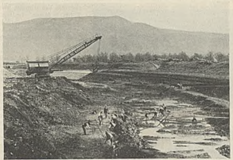
Abb. 5. Baggerarbeiten für den Hauptsammler des Beckens von Pisciara.
