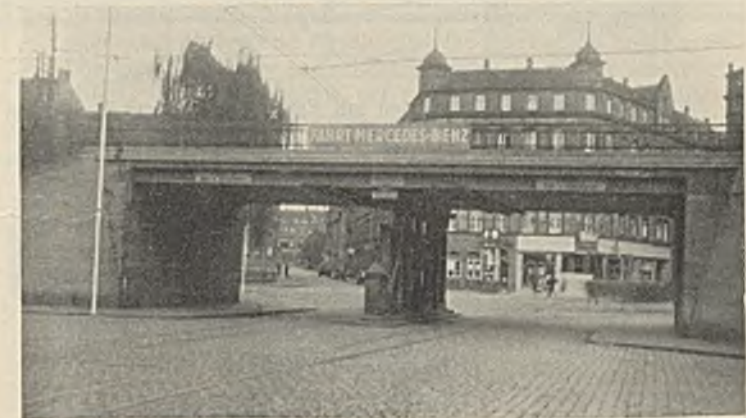
Abb. 9. Unterführung Schillerstraße vor dem Bau.
