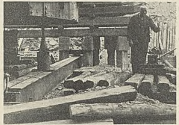
Abb. 15. Probebelastung eines Rammpfahles. Die beiden Stahlträger als Hebelarm, die Wasserdruckpresse, das Rammgerüst als Gegengewicht und die mit Pfählen beschwerten Zugpfähle, die zum Ansetzen des Hebels dienen, sind gut sichtbar (vgl. Abb. 4). Querschnitt des Rammpfahles 34/34 cm. Länge des Rammpfahles im Boden 6,20 m. Eindringung bei den letzten Schlägen 3,1 mm/Schlag. Höchstbelastung 127,5 t, Eindringung 6 mm, davon 2,2 mm bleibend.
