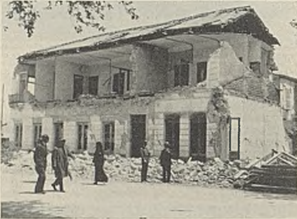
Abb. 2. Gebäudeschäden beim Erdbeben von Korinth, 1928.
