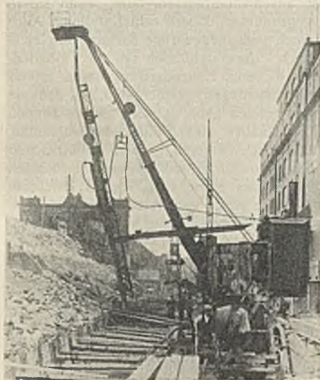
Abb. 14. Baugrube der Stützmauer und Rammhammer beim Rammen eines Schrägpfahles.
