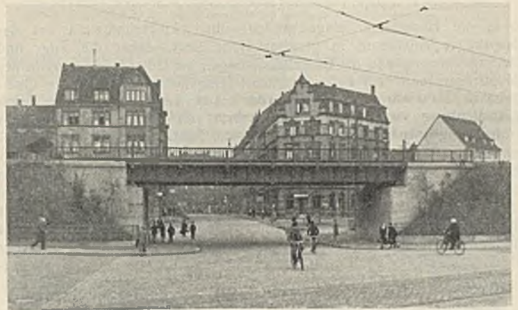
Abb. 8. Unterführung der Heinigstraße nach dem Bau.
