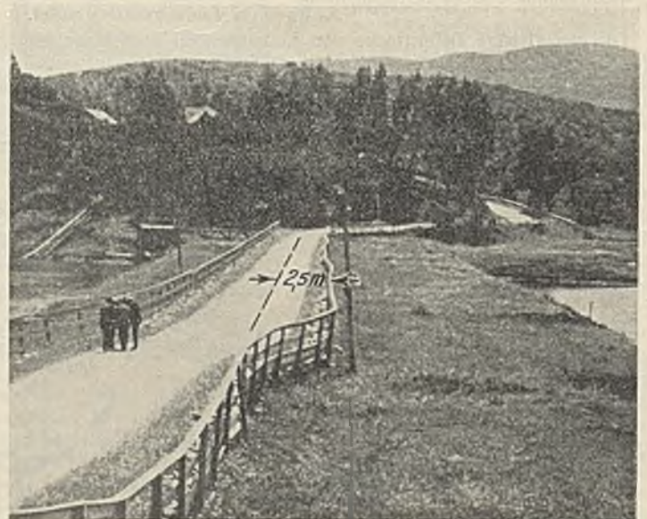
Abb. 5. San-Andreas-Damm; Geländeverschiebung von 2,5 m infolge Verwerfung beim kalifornischen Erdbeben 1906. (Nach Eng. News-Rec. vom 25. August 1932.)
