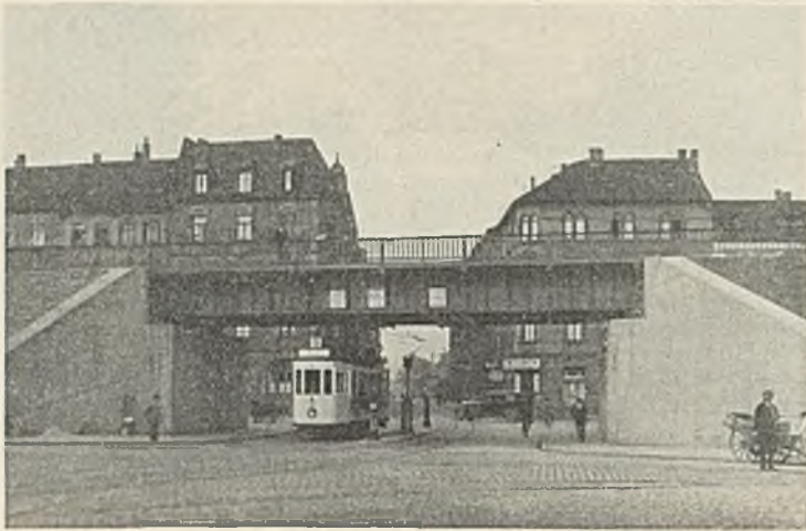
Abb. 10. Unterführung Schillerstraße nach dem Bau.
