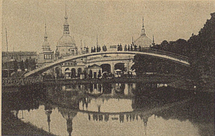
Abb. 2. Ausstellungsbrücke in Bremen (1890).
