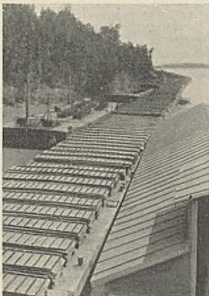
Abb. 2. Reihe der Bauprahme mit Gußformen.
