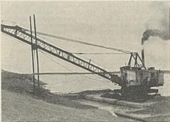
Abb. 1. Abgleichen der Überwasserböschung.
