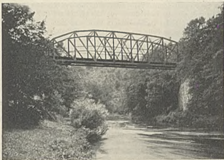
Abb. 1. Ansicht der alten Brücke.
