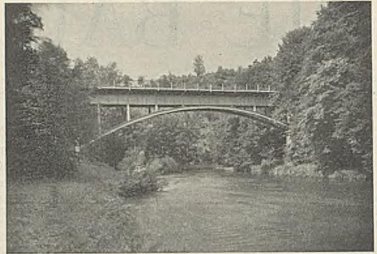
Abb. 5. Ansicht der Brücke nach dem Umbau.
