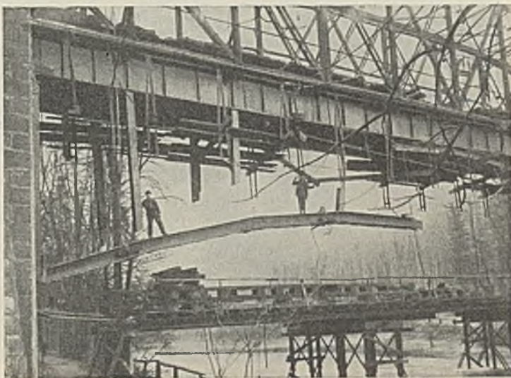
Abb. 18. Hochziehen eines Stab Bogenendes.
