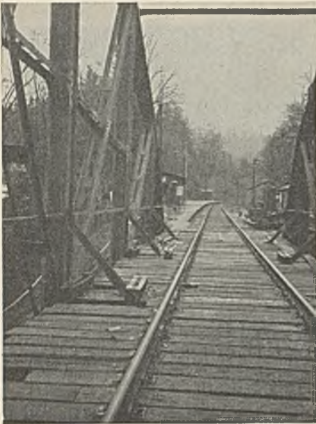
Abb. 11. Traversenaufhängung für den Versteifungsträger.
