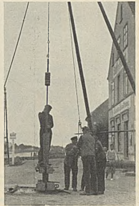
Abb. 10. Einrammen der Bodenstanze.
