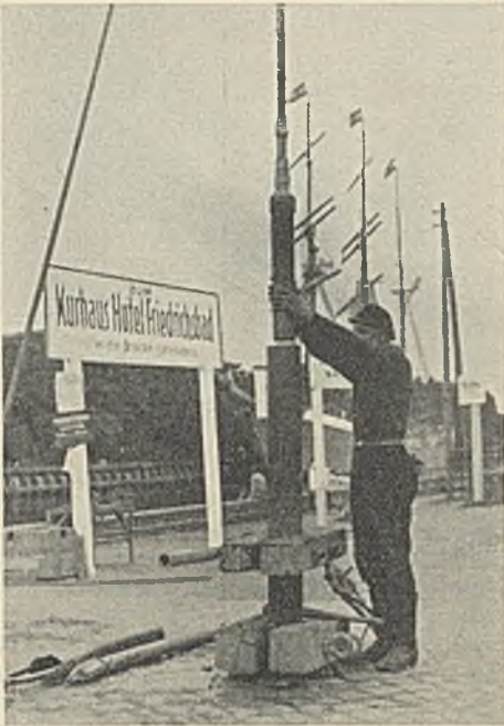
Abb. 9. Einführung der Bodenstanze.
