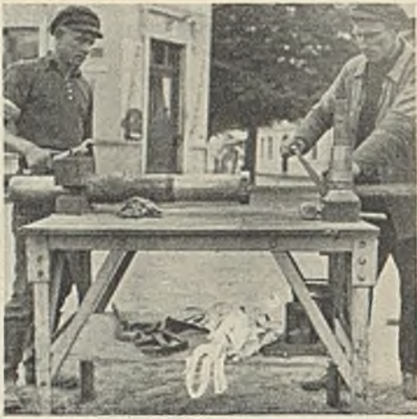
Abb. 12. Herausziehen der Hülse aus dem Zylinder der Bodenstanze.
