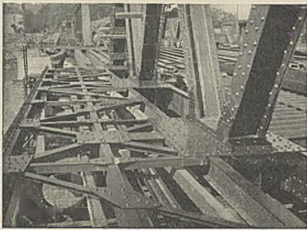
Abb. 31. Verband der Fußweg-Längsträger und Umrahmung der Diagonalen nach dem Einbau.
