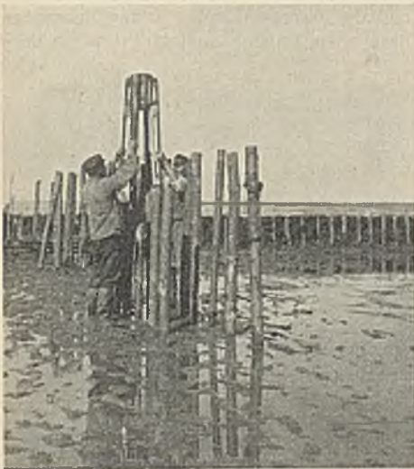
Abb. 53. Einschlagen von Pfählen mittels Kopframme.
