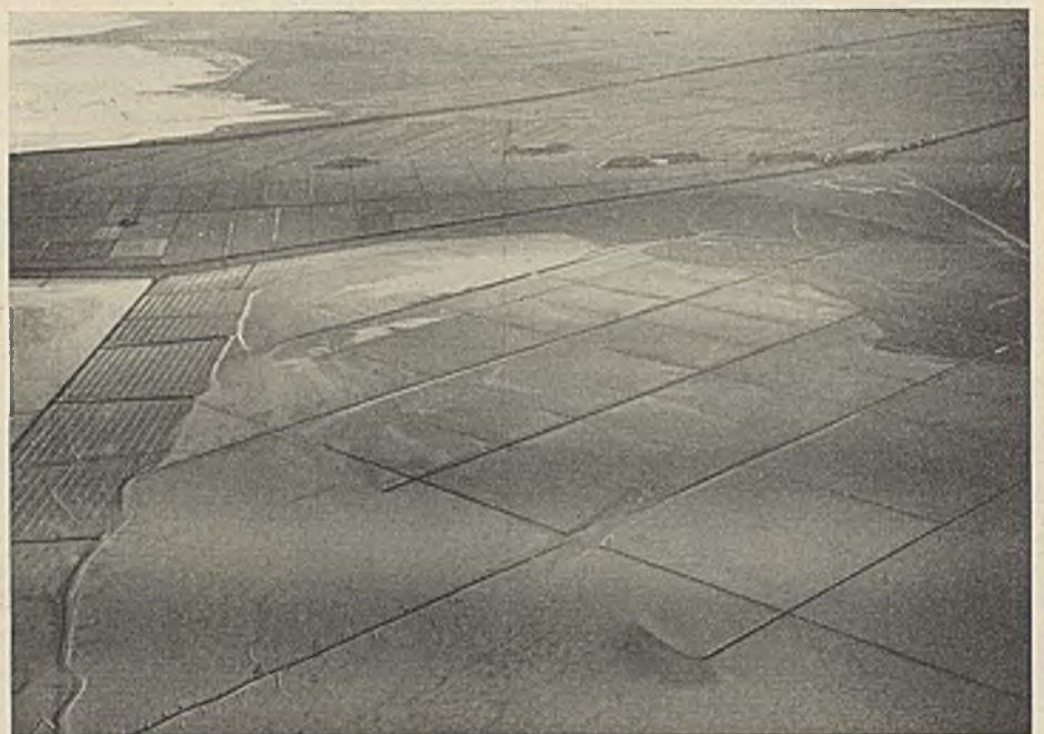
Abb. 62. Anschlickung am Damm nach Oland, links der Damm selbst.
