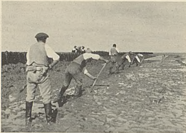
Abb. 58. Anwerfen von Boden an eine Lahnung.
