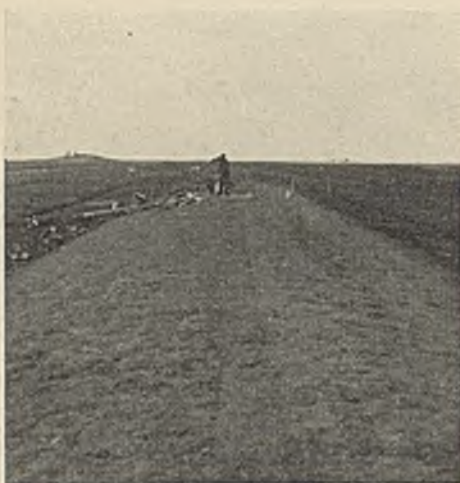
Abb. 61. Ausgebauter Rasendamm nach der Hamburger Hallig.
