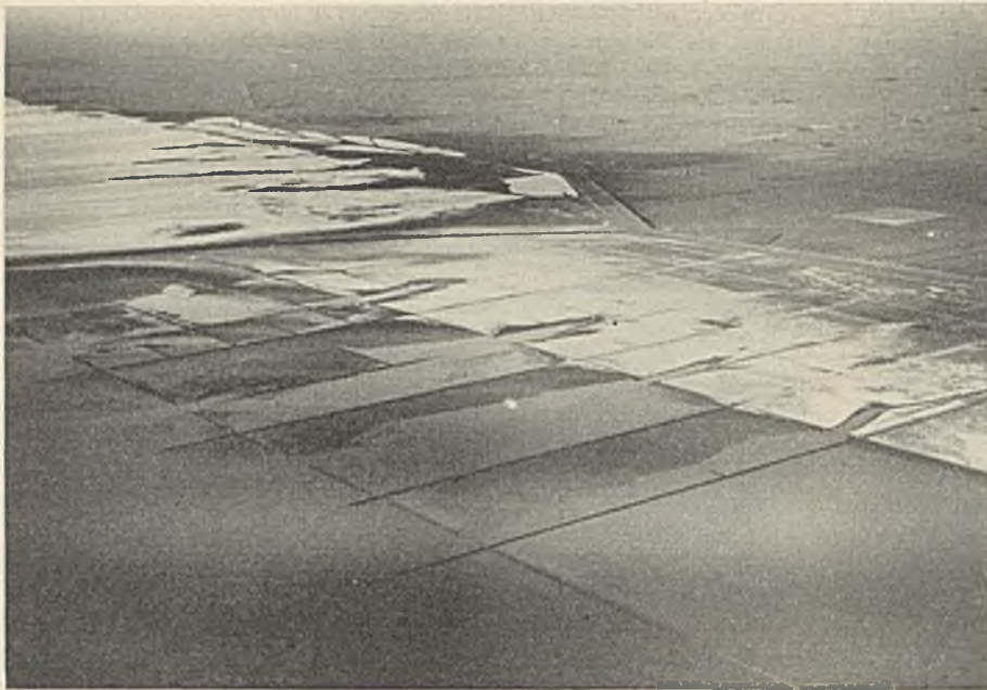
Abb. 87. Teil des Auflandungsgebietes südlich des Hindenburgdammes (links in der Mitte der Damm selbst).
