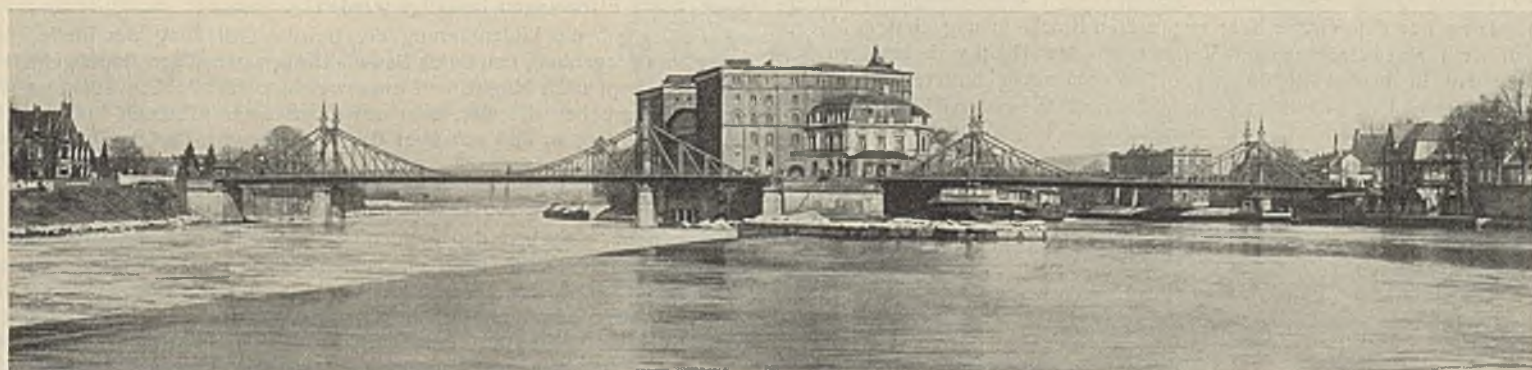
Abb. 2. Gesamtansicht der alten Brücke vom Oberwasser.
