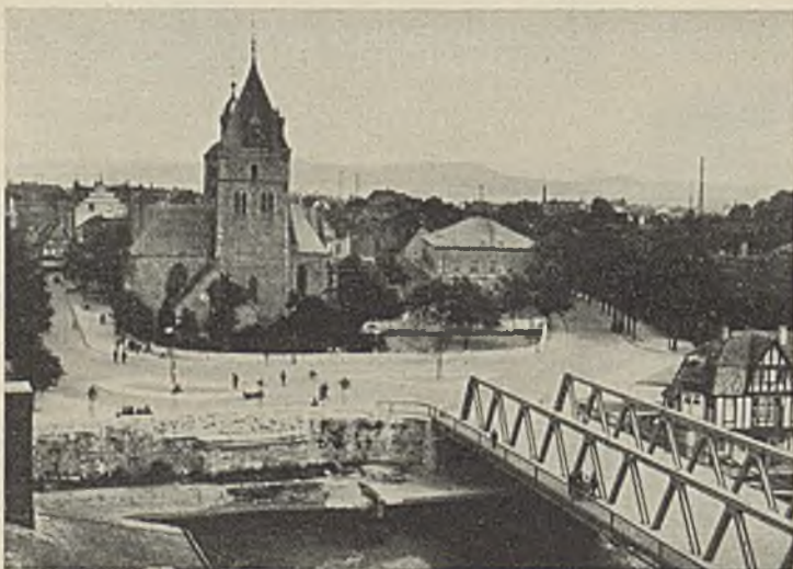
Abb. 8. Der neue Brückenvorplatz vor dem Münster.
