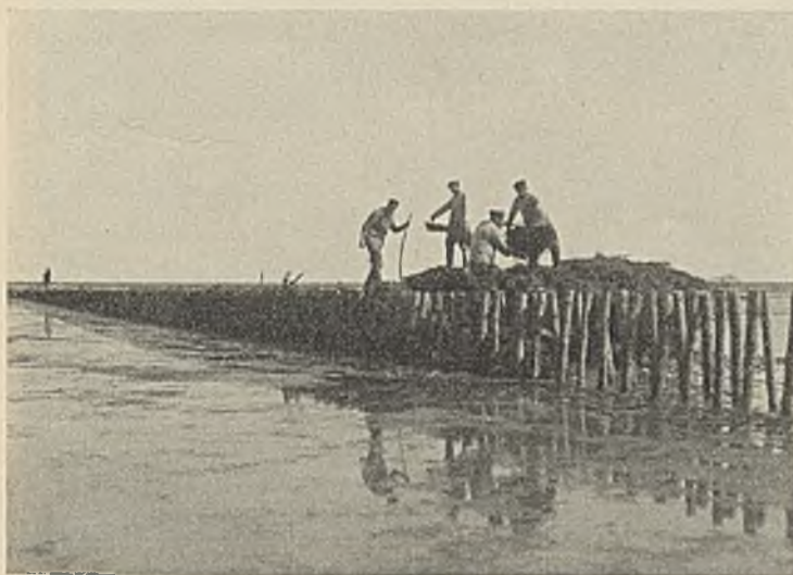
Abb. 54. Einbringen von Faschinen in die Lahnung.
