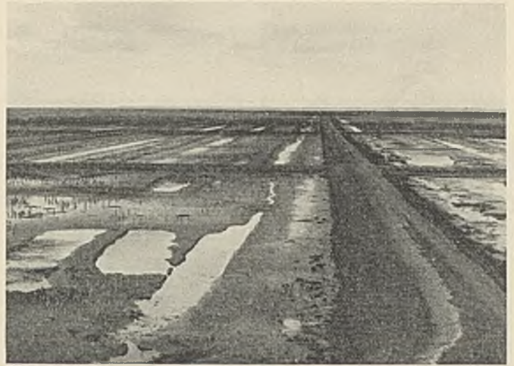
Abb. 71a u. b. Vernachlässigte Buschlahnung und unordentliche Schlickfläche.
