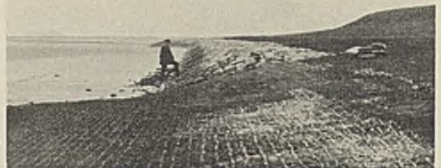
Abb. 84. Strohbestückung des Deichfußes.
