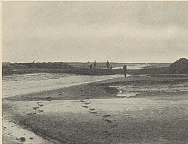
Abb. 43b. Prielabdämmung.
