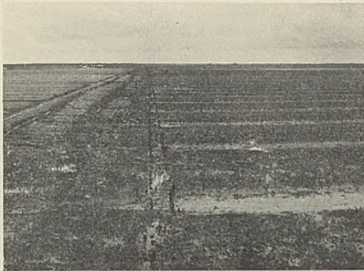
Abb. 77. Verschlickte Buschlahnung.
