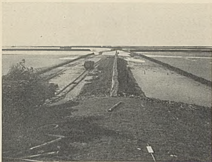
Abb. 43a. Bau eines Dammes als Wasserscheide vor Friedrichskoog.
