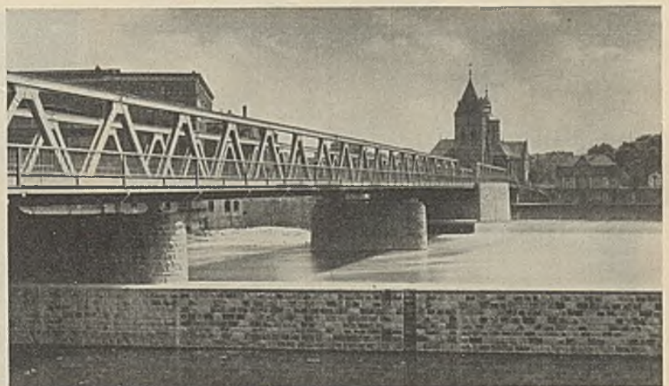
Abb. 5. Längssicht der neuen Brücke von der Klütseite.
