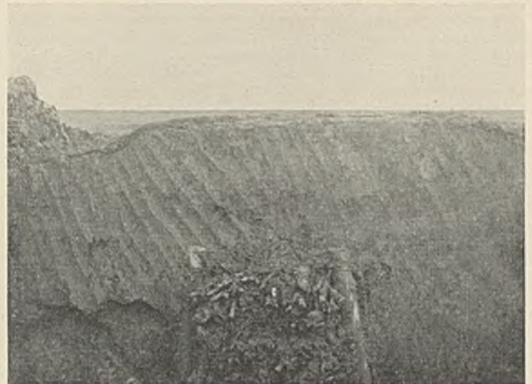
Abb. 78. Völlig eingeschlickte Buschlahnung.
