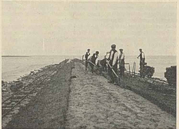
Abb. 49. Belegen des Dammes mit Grassoden.
