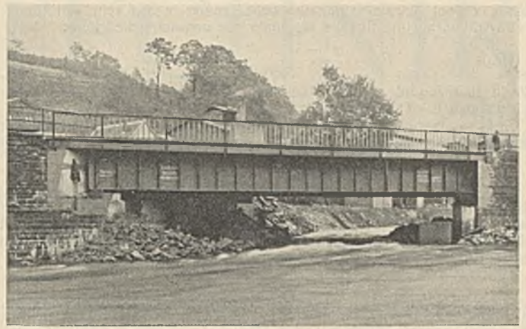
Abb. 19. Leppebrücke nach dem Einfahren.
