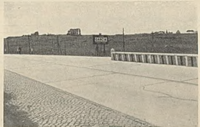
Abb. 10. Betondecken auf der Via Appia.
