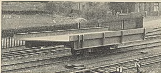
Abb. 11. Werkstattfertiger versandbereiter Überbau.
