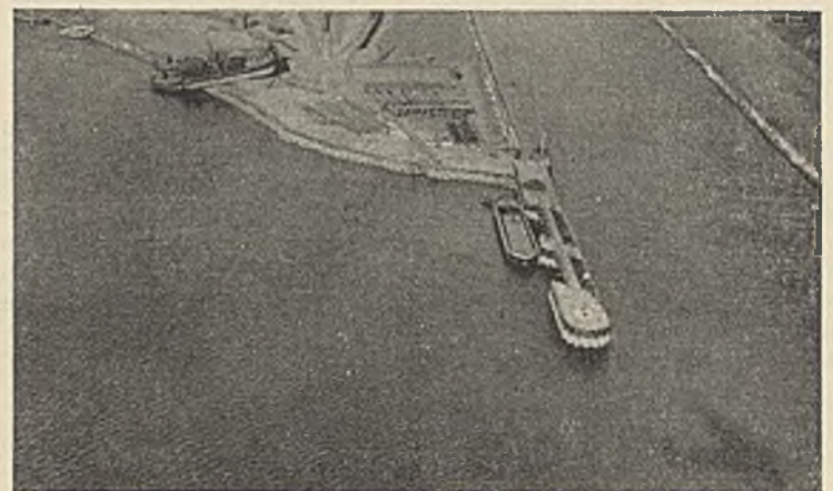
Abb. 8. Luftbild der fertigen Mole.
