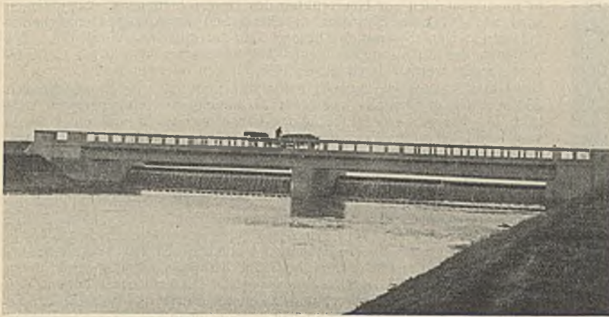
Abb. 2. Hydrostatische Klappenwehranlage. Zwei Wehre von je 20 m lichter Breite und 1,2 m Stauhöhe.
