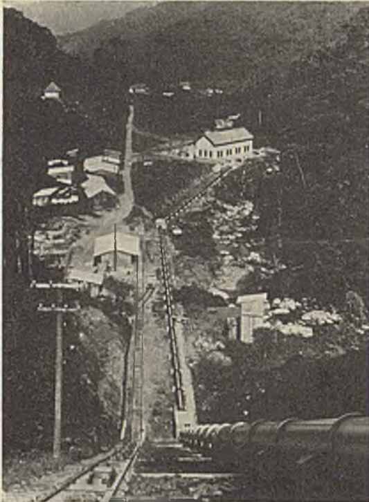
Abb. 4. Steinstrücke der Rohrbahn mit Druckrohrleitung und Krafthaus.
