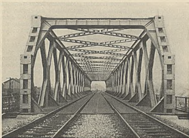
Abb. 17. Durchblick durch die fertigen Überbauten.
