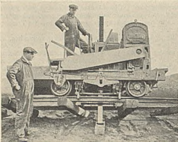
Abb. 4. Richtwagen in Betrieb. Gleis einseitig gehoben.
