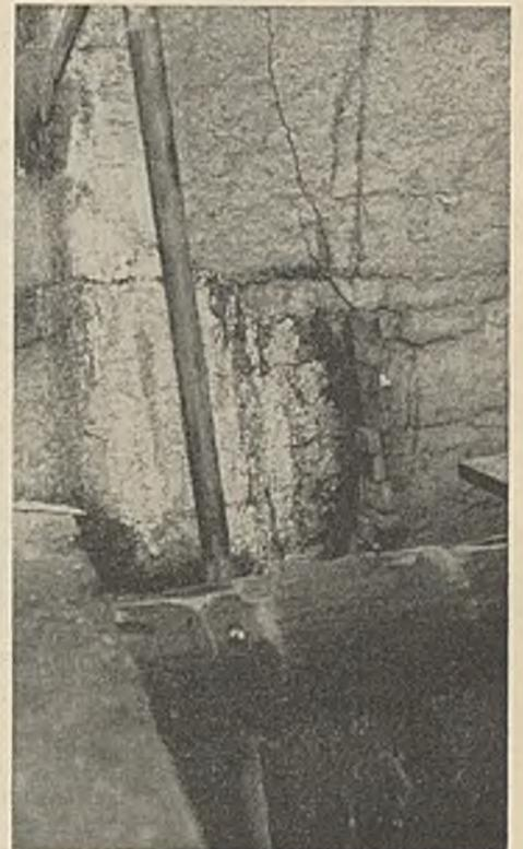
Abb. 3. Abdichtung der Wasserkraftanlage Grodek. Setzungsrisse in der Flügelmauer (zum Teil verkitet).
