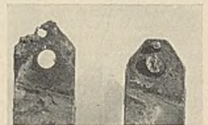
Abb. 11. Enden der Gegenschrägen nach dem Ausbau.
