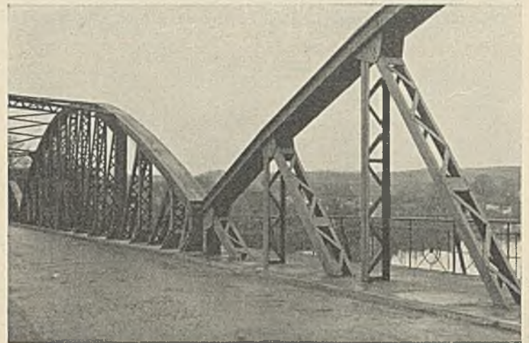
Abb. 10. Großer alter Überbau nach der Verstärkung. Rechts großer neuer Überbau.
