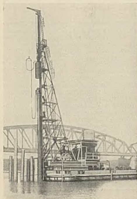
Abb. 1. Ansicht der 48-t-Pfahlramme.
