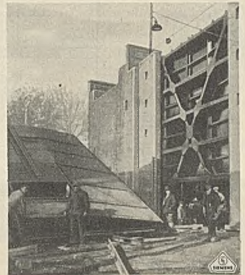
Abb. 2. Einbau der Schleusentore.
