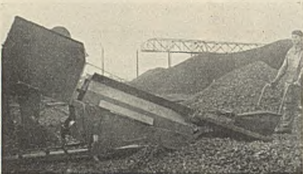
Abb. 2. Elektro-Handschrapper vor der Aufgabefläche eines Gurtförderers.
