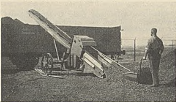
Abb. 1. Beladen eines Eisenbahnwagens mit Hilfe eines Elektro-Handschrappers.
