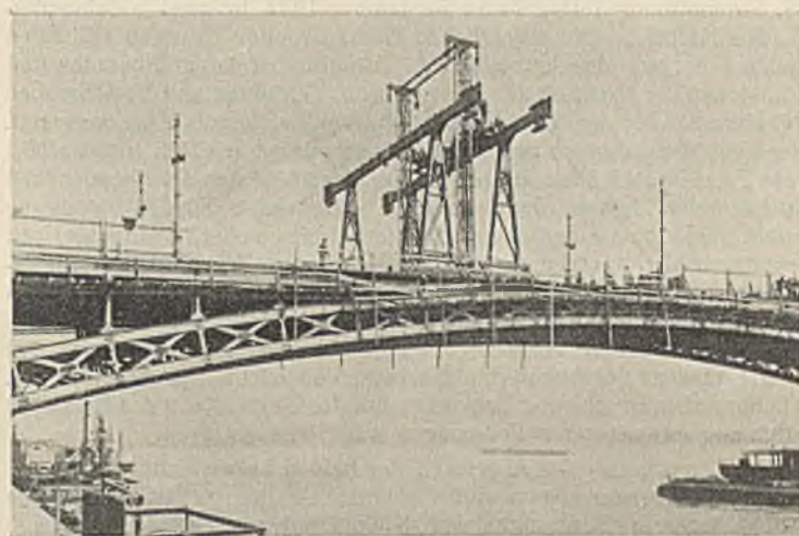
Abb. 9. Aufstellen der Montierwagen.
