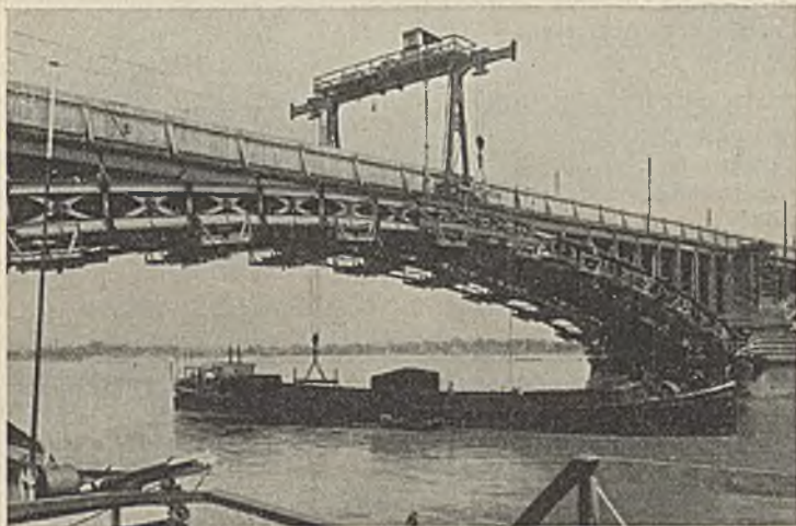
Abb. 10. Montage der Hauptträger.
