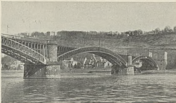
Abb. 2. Ansicht der bestehenden Strombrücke.
