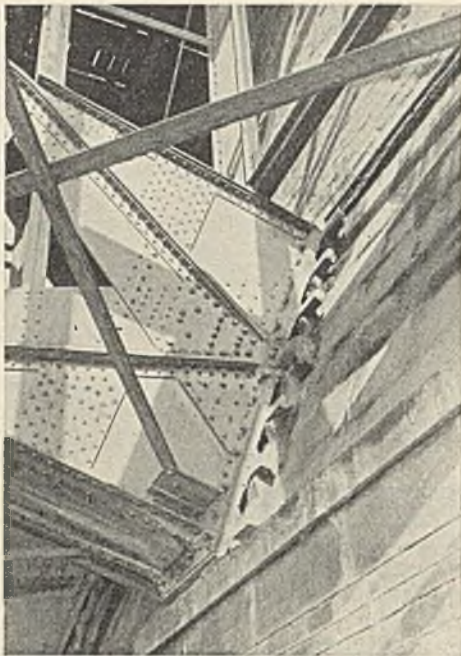
Abb. 5. Kämpfergelenk mit Hilfskeilen.
