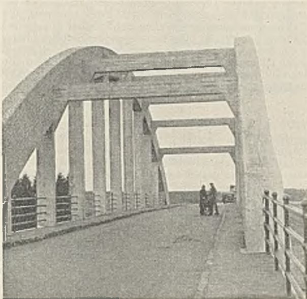
Abb. 9. Brücke bei Almen.
