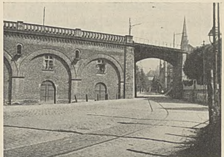
Abb. 12. Viadukt (Kasematten) und vorhandene Überbrückung der Emser Straße.
