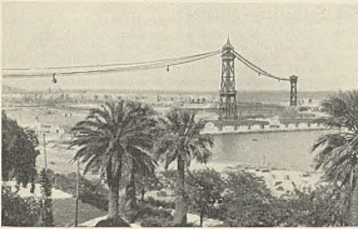
Abb. 6. Gesamtansicht der Schwebbahn von der Station Miramar aus gesehen.
