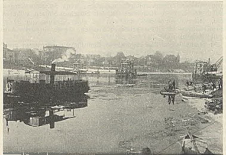
Abb. 7. Anschwimmen der Rohre an die Gerüste.
