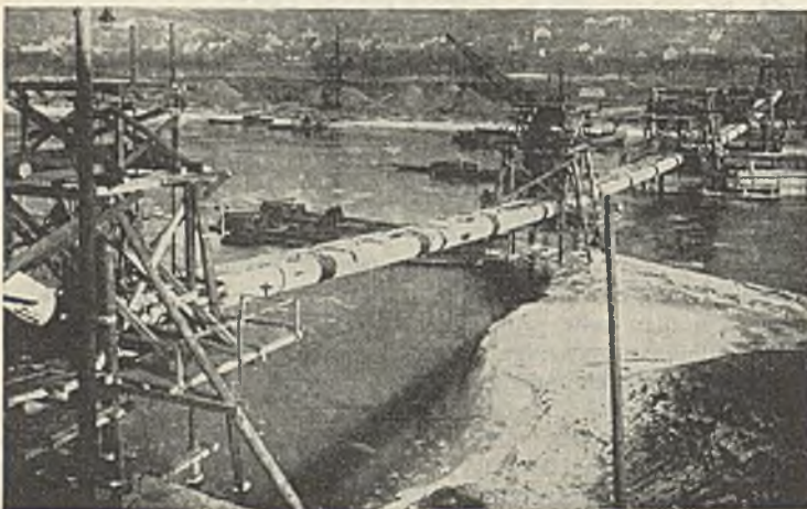
Abb. 8. Rohrstrang fertig auf das Gerüst verlegt.
