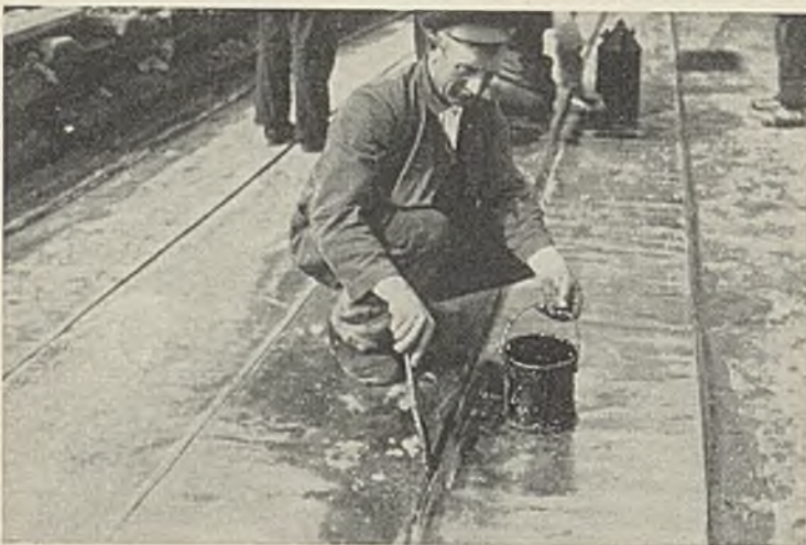
Abb. 5. Einbringen der Bitumendichtungsmasse zwischen die hochstehenden Abkantungen.
