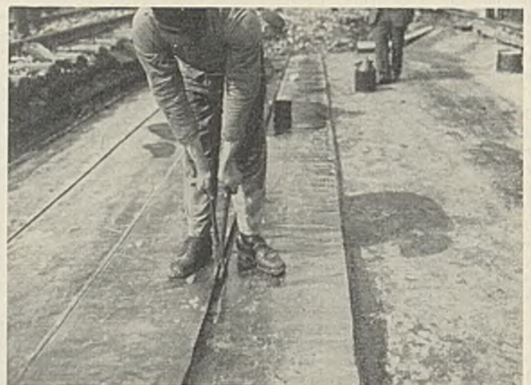
Abb. 6. Zusammendrücken der beiderseitigen Abkantungen.
