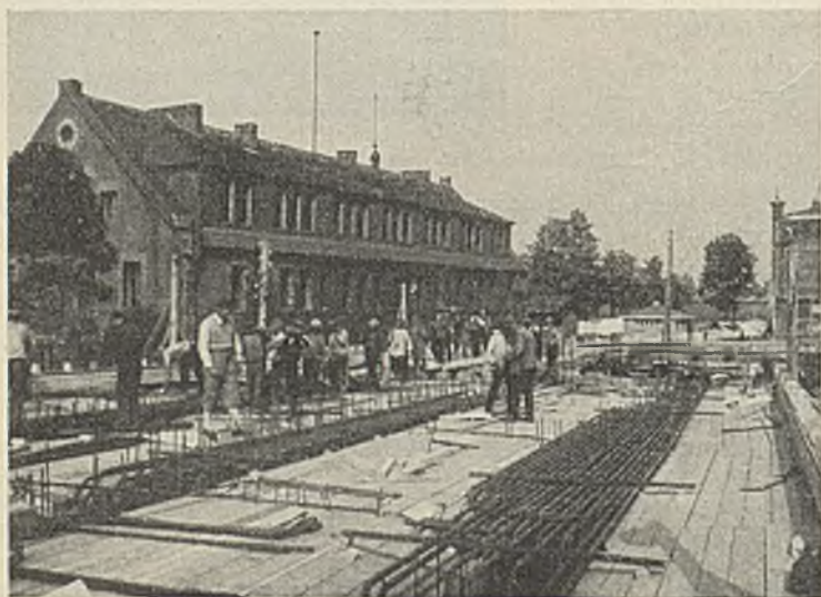
Abb. 11. Bewehrung der Hauptträger.
