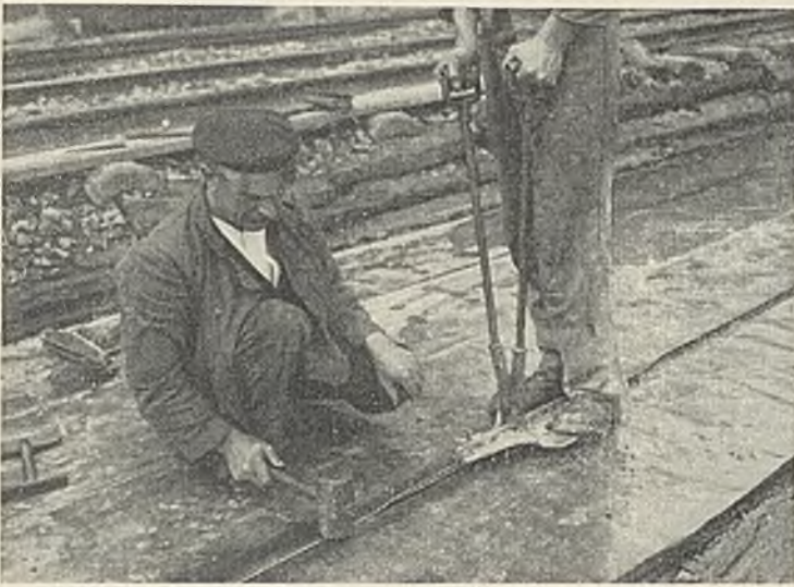
Abb. 7. Herstellung des Doppelfalzes und Niederlegen mit dem Holzhammer.
