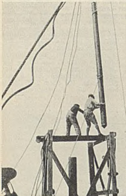
Abb. 2. Einführen der großen Sprengbomben in das Führungsrohr mit Hilfe des Mastkrans vom Prahm aus.
