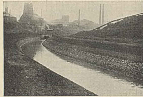
Abb. 60. Alte Emscher nach dem zweiten Ausbau. Bermen erhöht, Bachbett auf normales Maß eingeeengt.
