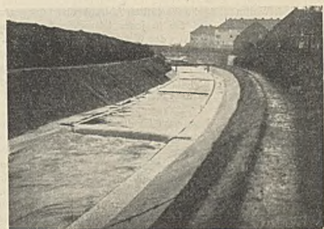
Abb. 19. Wirkung der „Wasserbremsen“ in der Schußstrecke (Abb. 18) bei HW.
