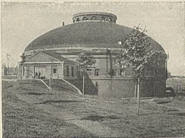
Abb. 7. Pumpwerk „Alte Emscher“.
