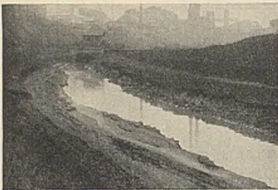
Abb. 59. Infolge des Kohlenabbaues wieder gesunken und verschlammte.
