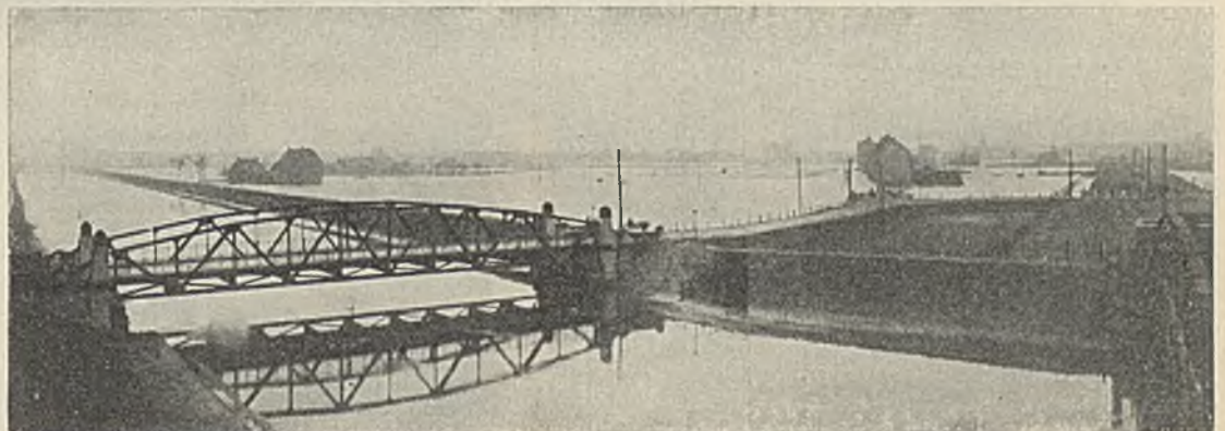
Abb. 8. Überschwemmung in Hamborn am Rhein Neujahr 1926. Vorn die Emscher im Rückstau des Rheins. Dahinter Gelände, das von Regen und Drängewasser überflutet ist.
