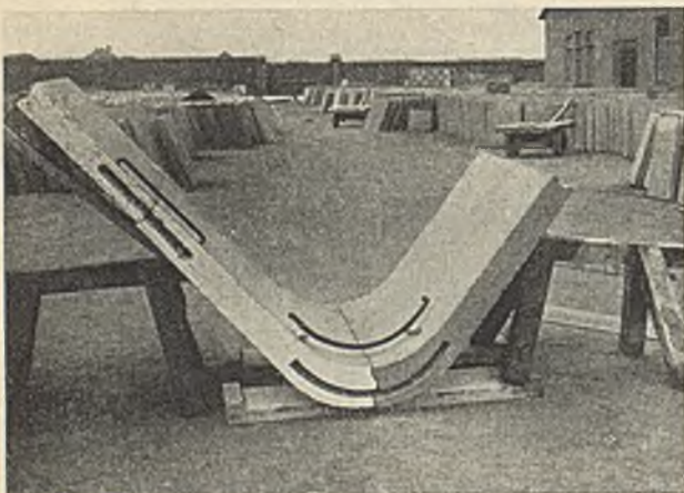
Abb. 13. Betonformsteine für das Profil C mit den Aussparungen für das Einbetonieren der Eisenbügel.
