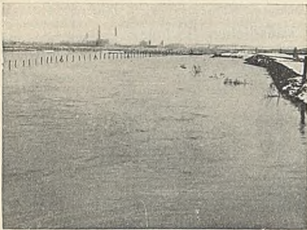
Abb. 2. Emscher im Süden von Recklinghausen. Vor dem Ausbau 150 ha bei Hochwasser überflutet.
