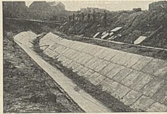
Abb. 58. Während des ersten Ausbaues.
