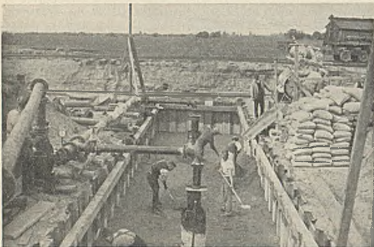
Abb. 13. Betonieren des Fundaments des Pfeilers 10 bei Wasserhaltung durch zwei Brunnen.
