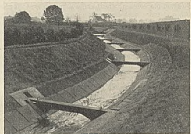
Abb. 18. Schußstrecke eines Bachlaufes mit nachträglich eingebauten „Wasserbremsen“.
