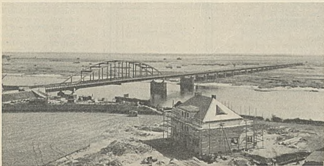
Abb. 1. Ansicht des Gesamtbauwerks.
