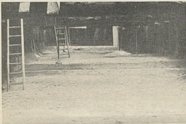
Abb. 9. Baugrube des Strompfeilers 2 beim Einbringen der ersten Betonschicht.
