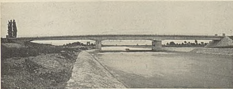
Abb. 2. Gemeindewegbrücke bei Neumühl. Gesamtansicht.
